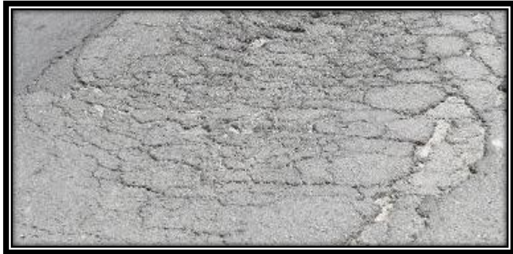
Fig. 2.12 Agrietamiento parabólico
