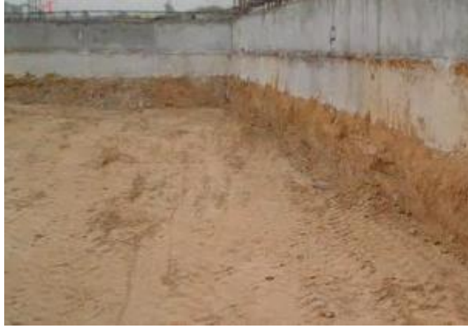
Figura 24. Excavación del núcleo
