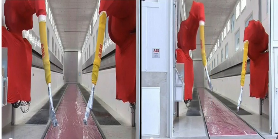
Figura 2.1: Cámara de aplicación de recubrimiento y secado de aspas de la empresa Enercon, automatizada por dos robots ABB articulados servocontrolados.
