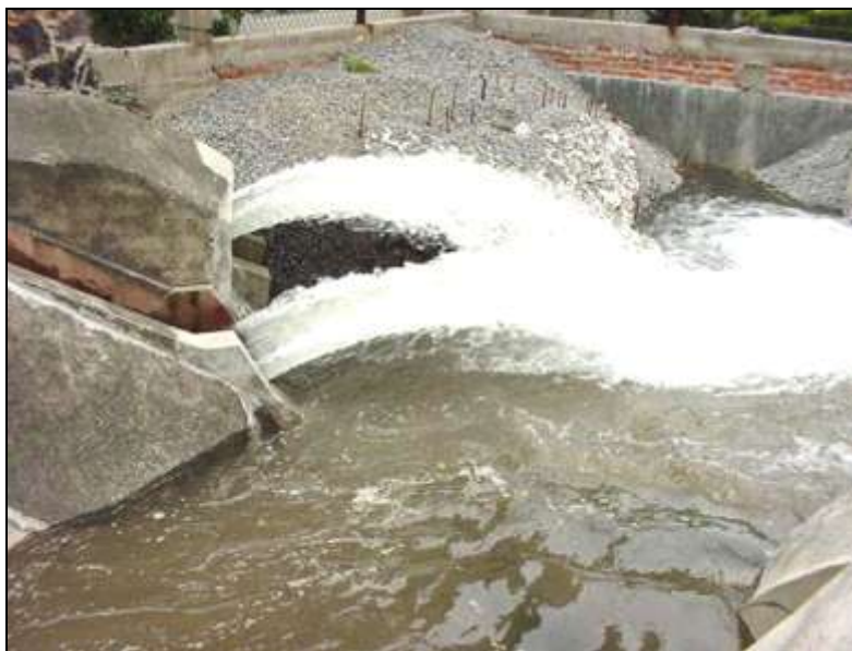
Foto 2 Vista del funcionamiento de la estructura terminal de la obra de excedencias, modelo de la presa La Angostura.
