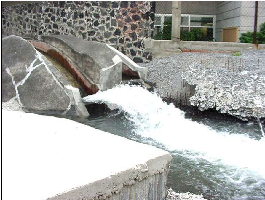
Foto 1 Vista del modelo de la obra de excedencias de la presa La Angostura
