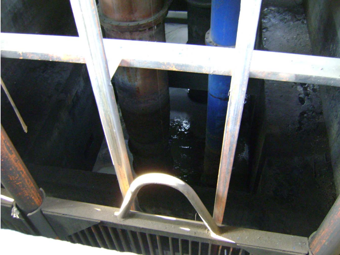
Figura 5 vista al interior de un cárcamo húmedo
