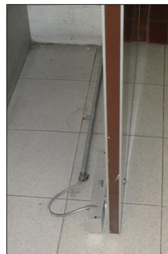
Figura 3.46. Electroimán para puerta abierta
