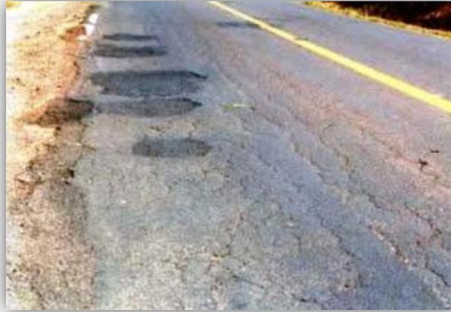
Fig. 2.19. Grietas longitudinales ocasionadas por suelos expansivos.
