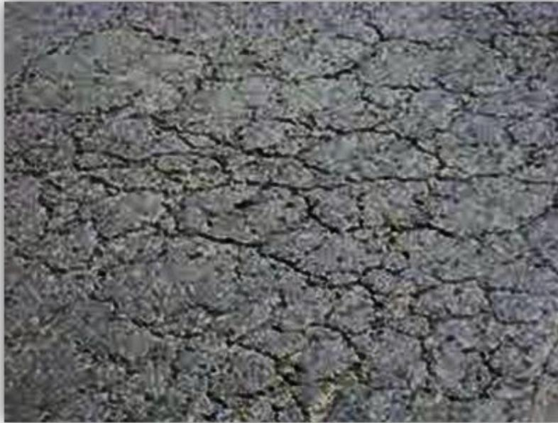
Fig. 2.7. La falla por fatiga de la estructura de un pavimento asfáltico es una de las causantes de la formación de agrietamientos reticulares.
