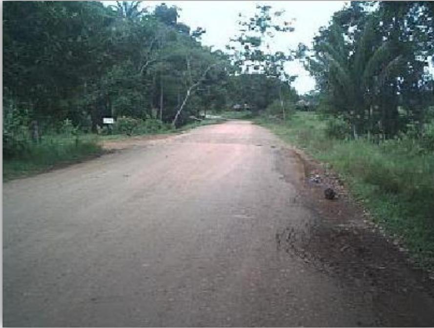
Fig. 2.10. Un pavimento que empieza a fallar debido a la ausencia o deficiencia de subdrenaje.
