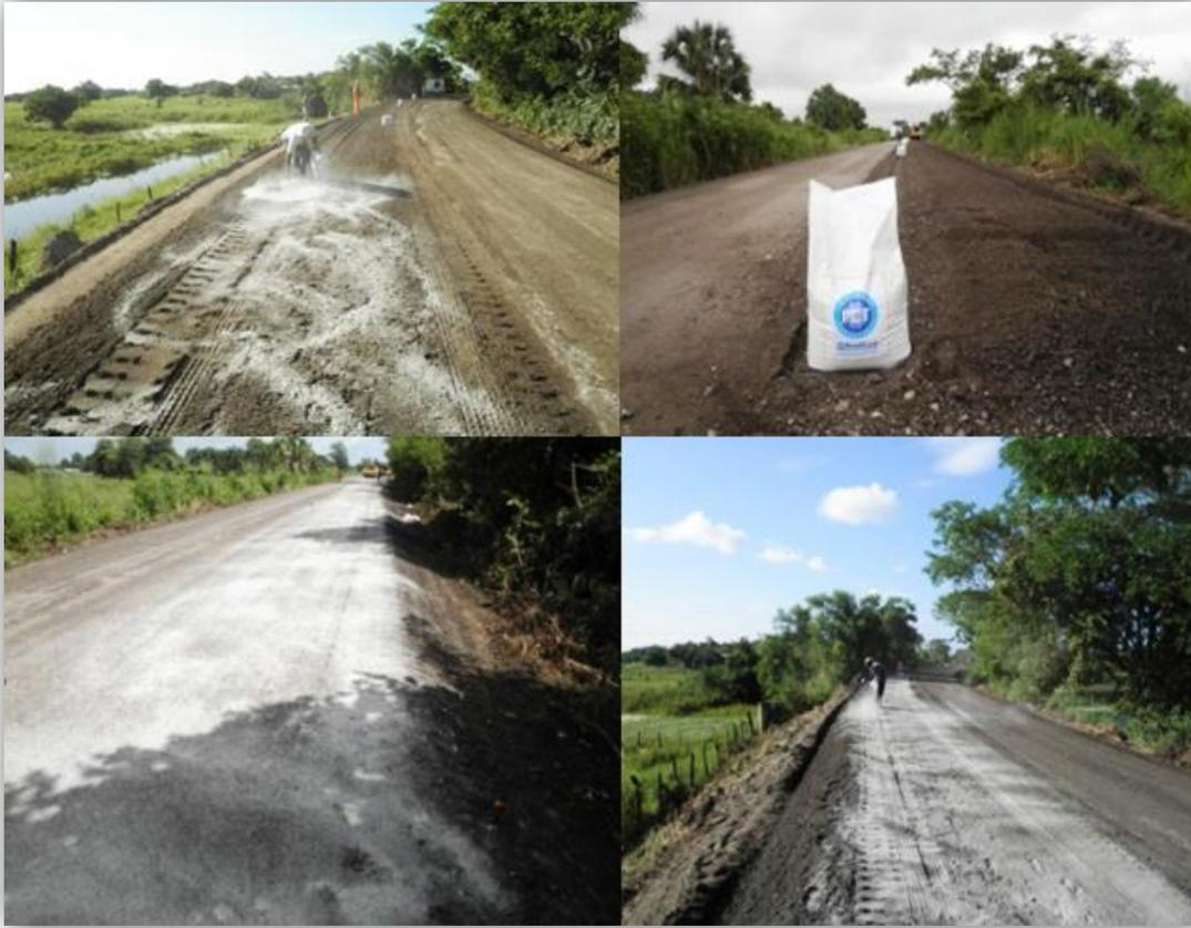
Fig. 3.28. Distribución de los sacos que contienen la zeolita sintética RoadCem®
