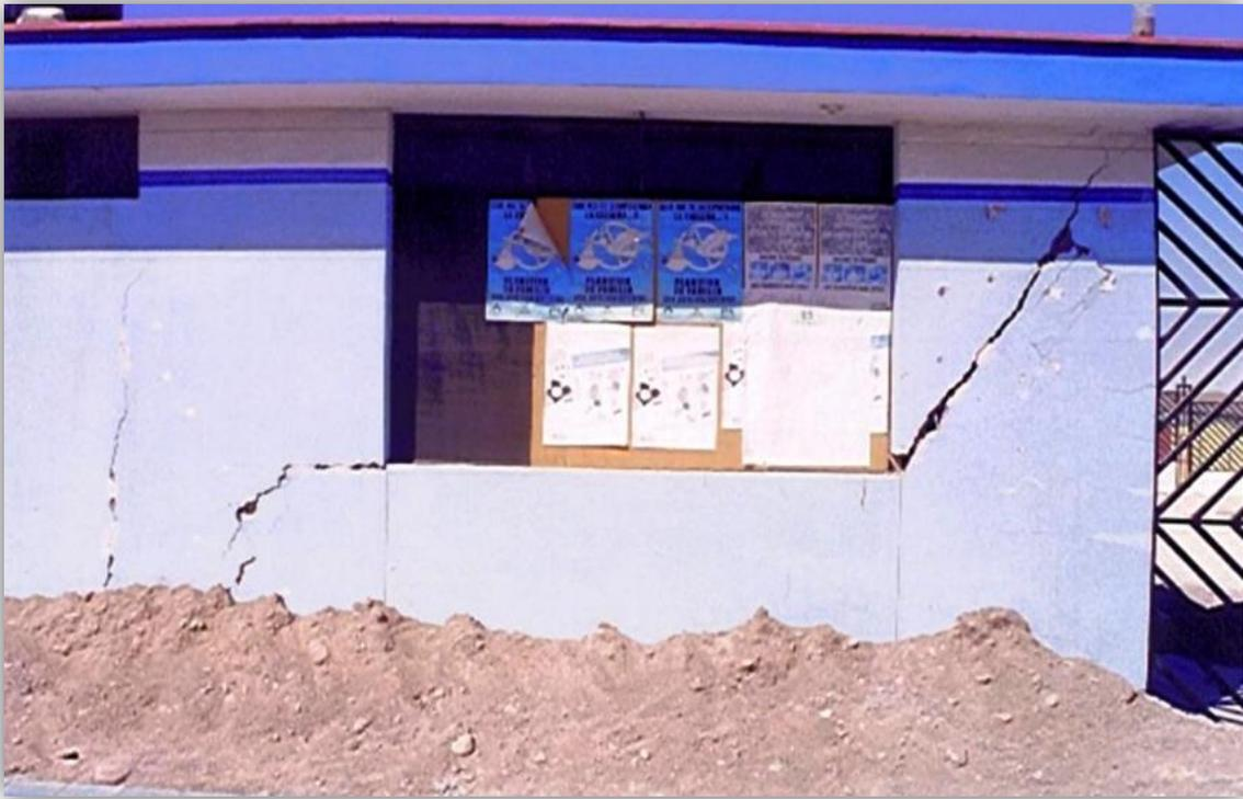
Fig. 2. Daños estructurales en un centro de salud ubicado en Moquegua Perú, por la presencia de suelos expansivos.
