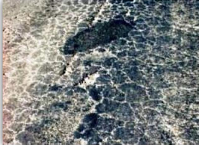
Fig. 2.21. Piel de cocodrilo en la superficie de un pavimento flexible.
