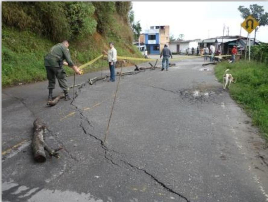
Fig. 2.9. Falla de un pavimento asfáltico debido a defectos en la compactación de las capas inferiores, las cuales se han consolidado.
