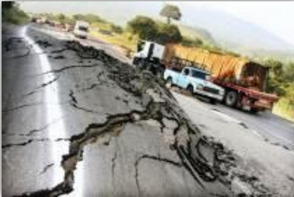
Fig. 5. Pavimento completamente destruido por los efectos nocivos de los suelos expansivos.
