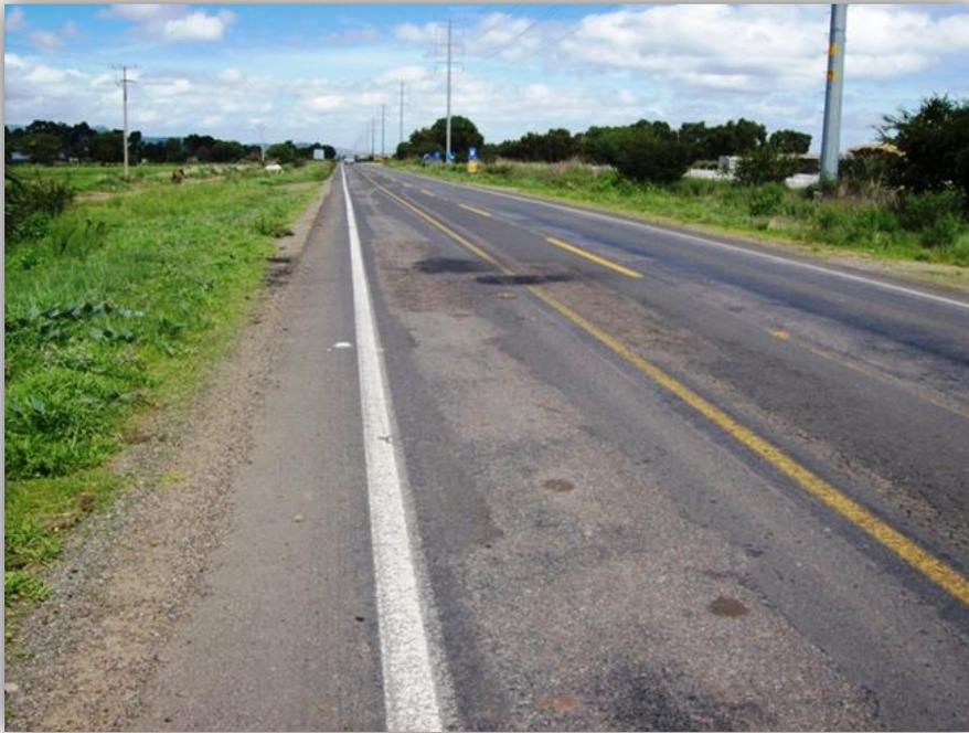
Fig. 4.13. Km. 16+800 vista hacia atrás (hacia el entronque de Buenavista) mostrando el estado de la carpeta actual con roderas, baches y deformaciones longitudinales.
