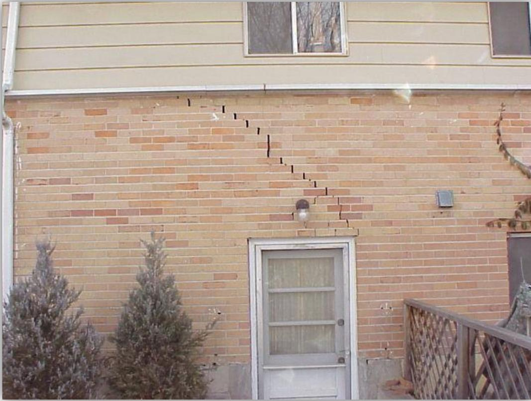
Fig. 4. Casa de mampostería en Australia con afectaciones debidas a suelos expansivos.
