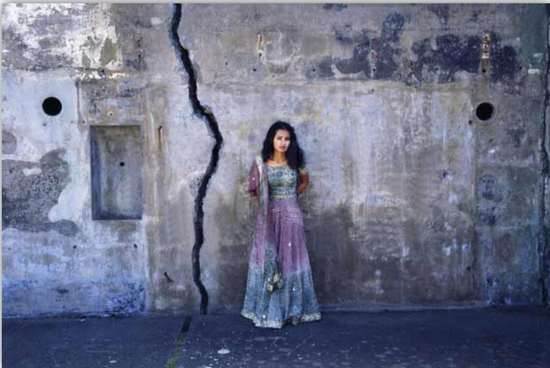
Fig. 3. Grieta vertical en una vivienda provocada por suelos expansivos en La India.
