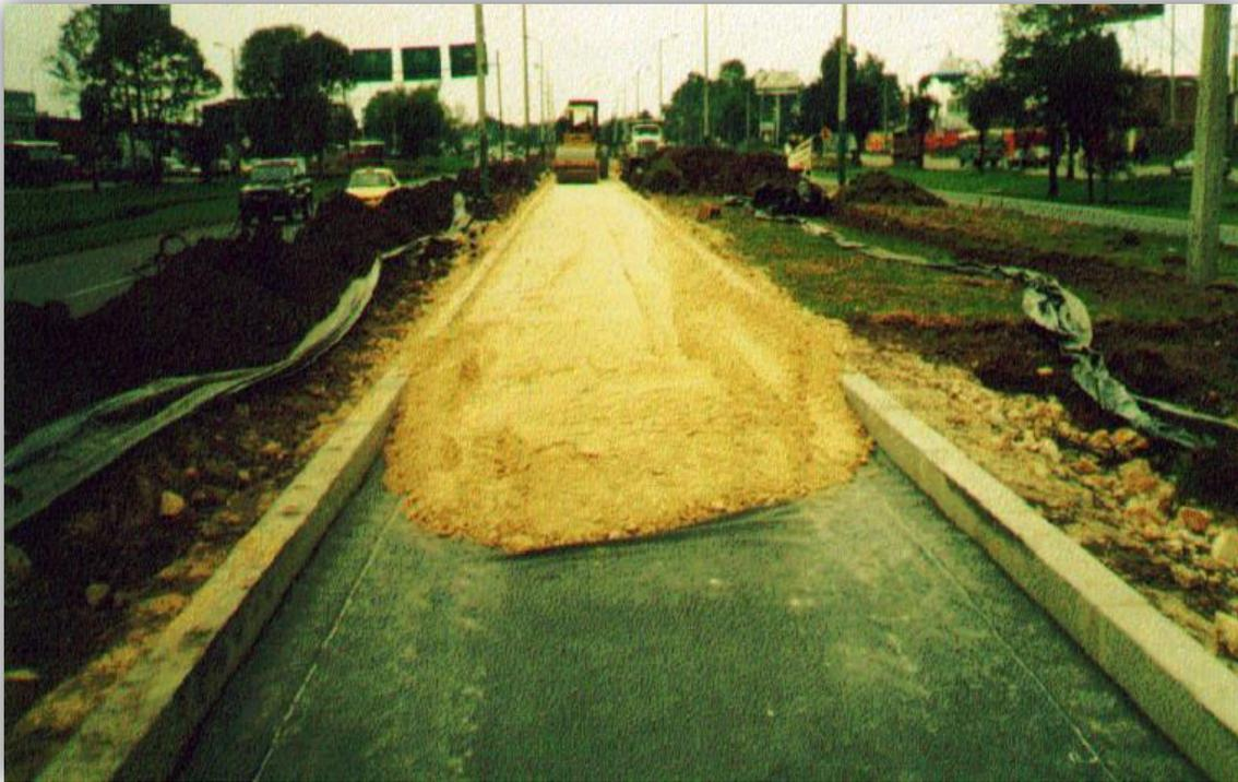
Fig. 3.20. Empleo de un sistema compuesto por geomembranas para evitar el contacto entre dos materiales cuya interacción podría perjudicar la estructura de pavimento que se pretende construir (referencia 24).
