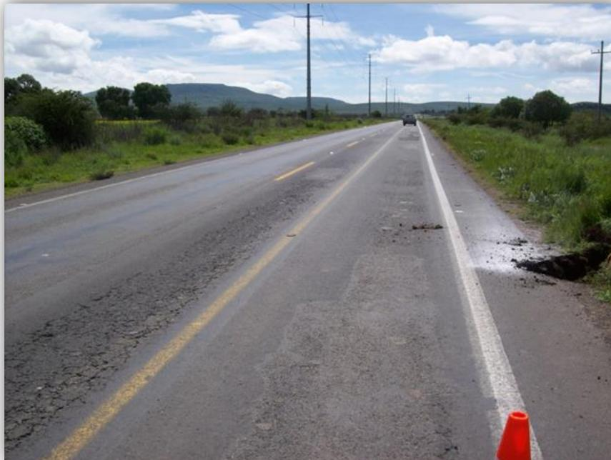
Fig. 4.14. Km. 16+800 vista hacia adelante (hacia San Miguel de Allende) mostrando pavimento actual con roderas y grietas en carril derecho. Se puede apreciar en la parte derecha de la foto la excavación que se está realizando para lo que será una cala, la cual, permitirá observar las capas del pavimento actual, así como la toma de muestras para determinar las propiedades físicas y mecánicas de dichas capas.
