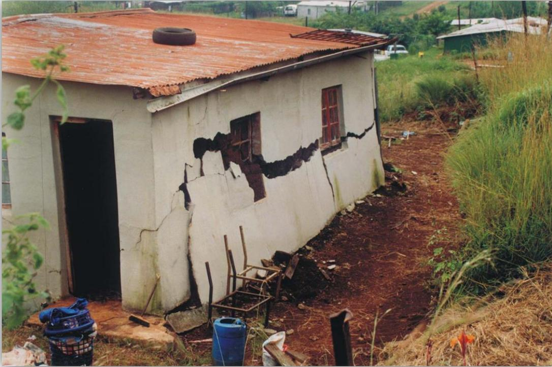
Fig. 1. Daños estructurales en una casa habitación por la presencia de suelo expansivo en Sudáfrica.
