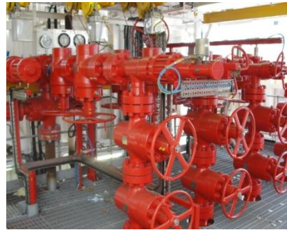
Ilustración 56 Árbol de estrangulación
