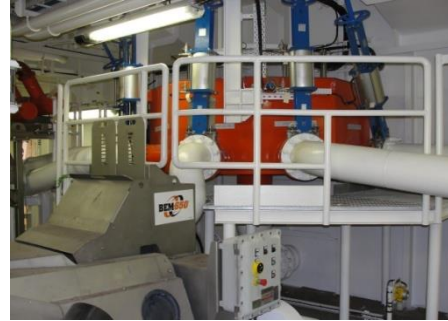
Ilustración 50 Desviador de flujo
