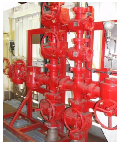
Ilustración 58 Manifold de cementación
