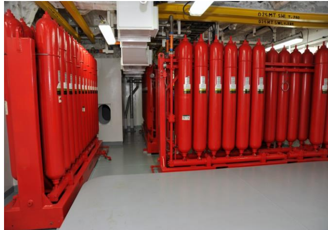
Ilustración 68 Botellas acumuladoras de fluido para el conjunto de preventores
