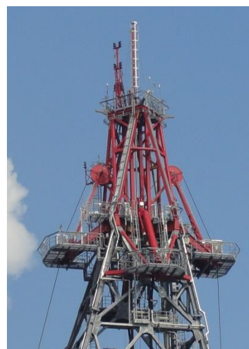
Ilustración 29 Corona de la PSS Bicentenario
