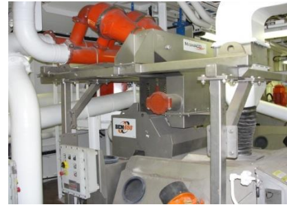
Ilustración 53 Desarenador
