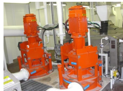
Ilustración 55 Desgasificadores
