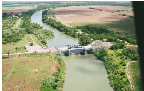
Imagen II.2.2.11. Vista panorámica de la Presa El Retamal.
