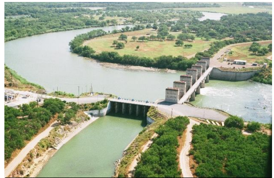
Imagen II.2.2.10. Vista panorámica de la Presa Anzaldúas.
