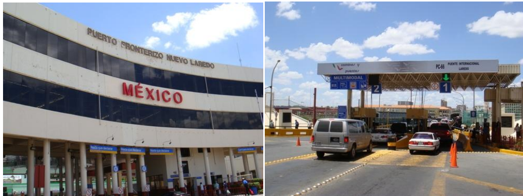
Imagen II.2.2.13. Acceso a aduana Mexicana en Nuevo Laredo, Tamps. Puentes Internacionales 1 y 2. (Fuente: Fuente: Google earth, 2011.)
