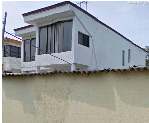
Figura 5.1. Estado actual de la vivienda. 1
