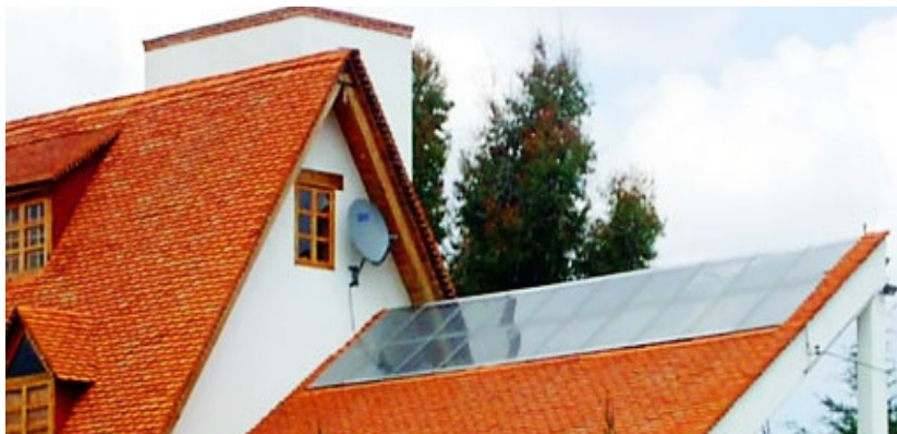
Figura 2.15. Instalación de un calentador solar incorporado en la edificación de la vivienda. 1
