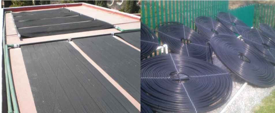
Figura 2.17. Calentadores solares para albercas. 1
