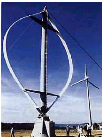
Figura 4.3. Ejemplo de aerogeneradores de eje horizontal (Derecha) y de eje vertical del tipo Darrieus (Izquierda). 1
