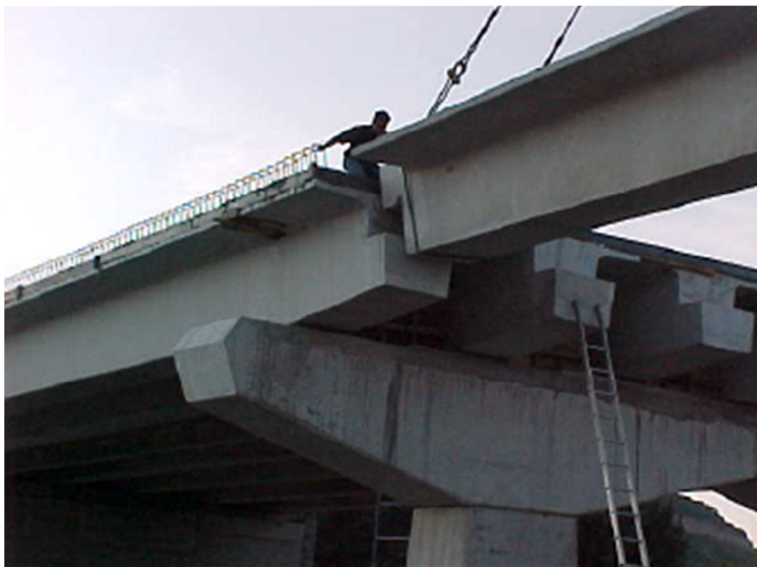
Figura 4.4.3 Imagen de un montaje real de una Trabe central
