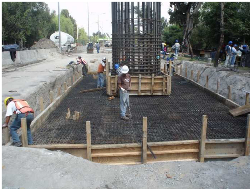
Figura 4.2.6.1 Armado de zapata y dado, inicio del armado de la columna
