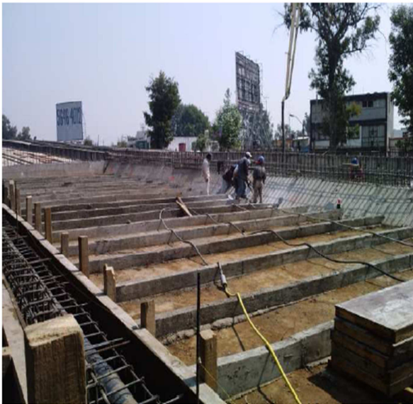
Figura 4.3.3.2.2.1 Tensores y rellenos con material de banco
