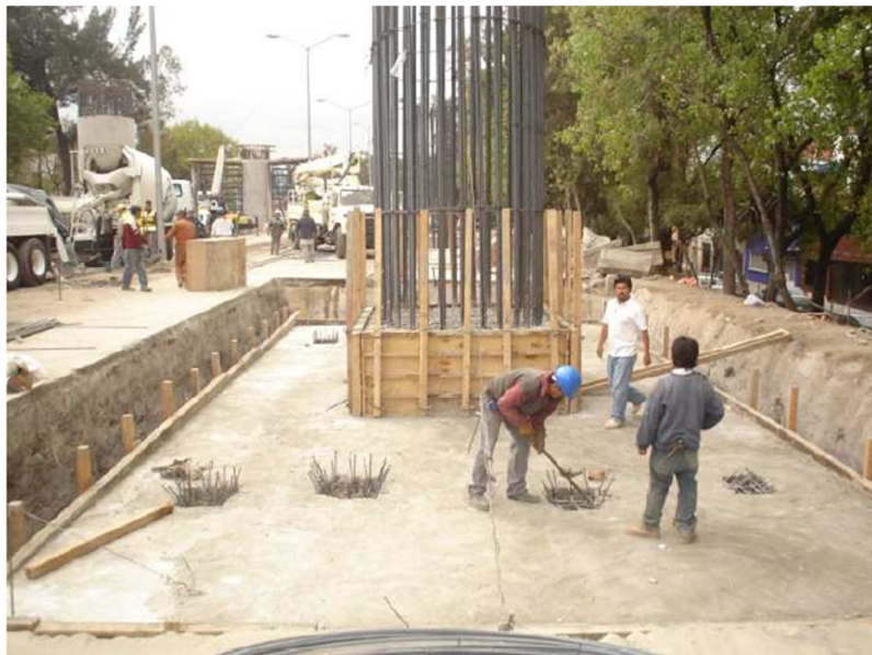
Figura 4.2.8.1 Colado de Zapata y Dado
