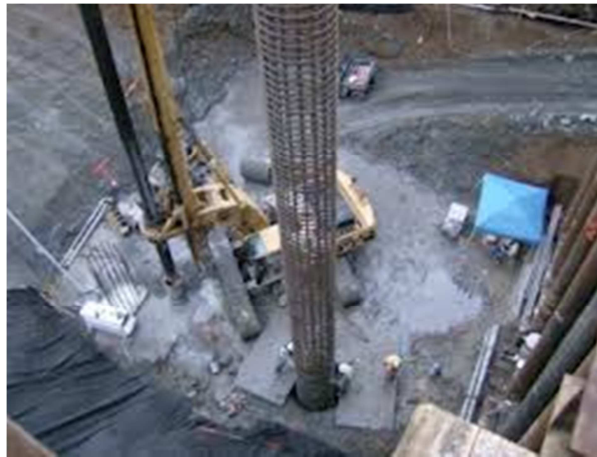
Figura 4.1.1.3.2 Colocación del armado de acero dentro de la excavación
