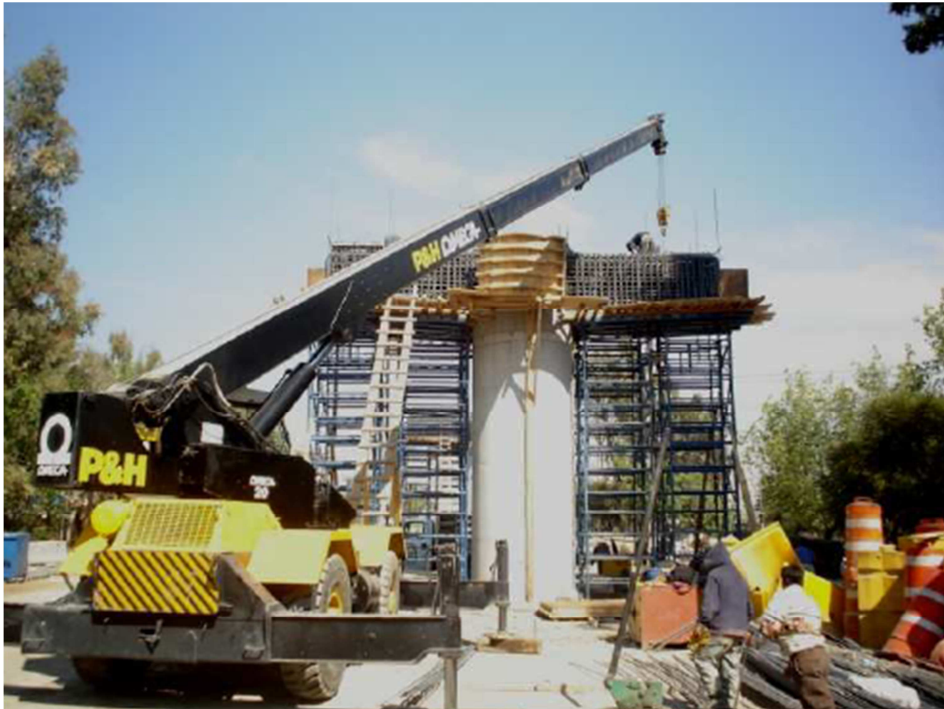
Figura 4.3.3.1.1 Colocación de cimbra para el colado del cabezal
