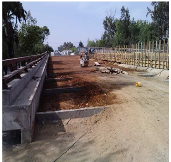
Figura 4.3.3.2.2.1 Tensores y rellenos con material de banco
