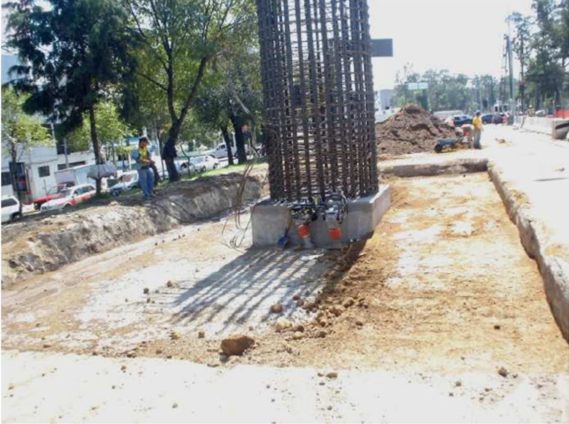
Figura 4.2.9.2 Relleno y compactación con material de banco
