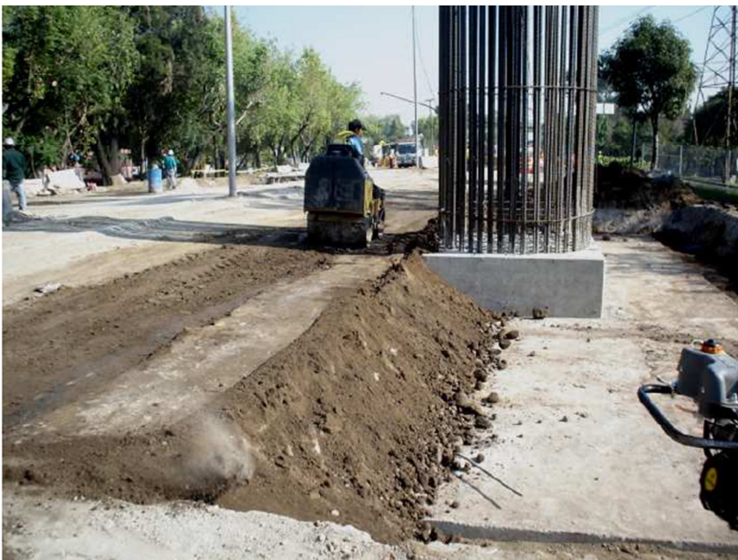
Figura 4.2.9.1 Relleno y compactación con material de banco
