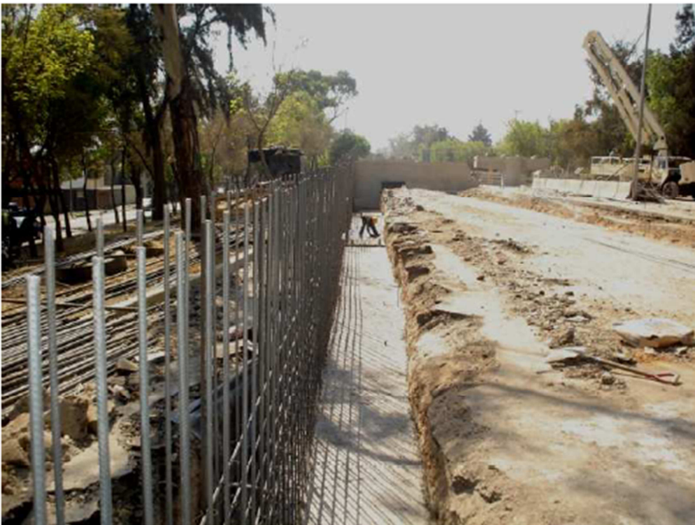
Figura 4.3.3.2.1.1 Excavación del terreno y armado de muros de contención
