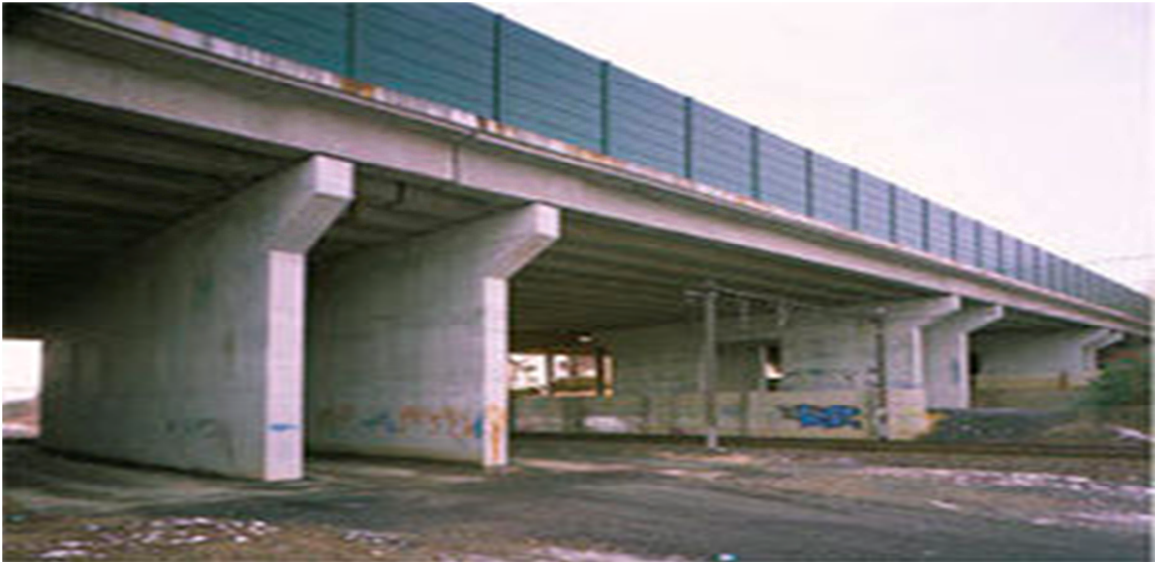
Figura 3.1.1 Puente tipo viga
