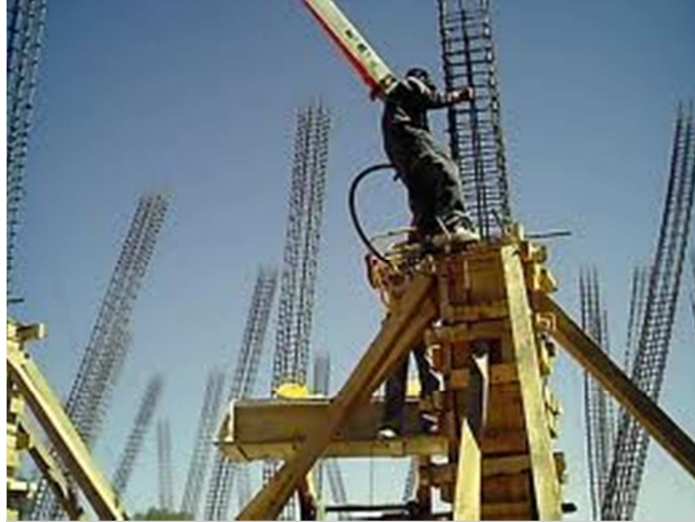
Figura 4.3.1.4 Colado de columnas
