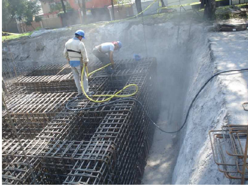
Figura 4.2.7.1 Limpieza del armado antes de la colocación de la cimbra
