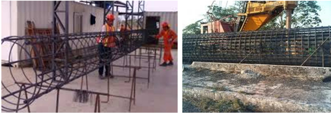
Figura 4.1.1.3.1 Armado de acero de refuerzo para pilas y pilastrones
