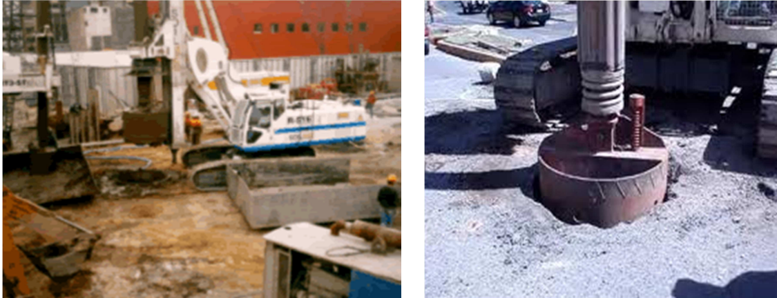
Figura 4.1.1.2.1 Perforación para pilas y pilastrones
