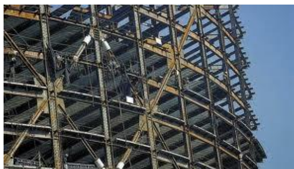
Figura 1.1.6 Construcción del Edificio Torre Mayor, D.F, México, 2002
