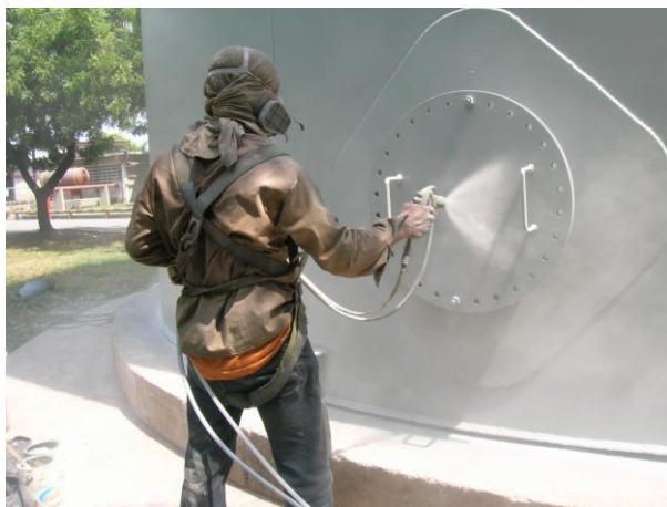
Figura 8.3.1 Aplicación de pintura por medio de atomizador
