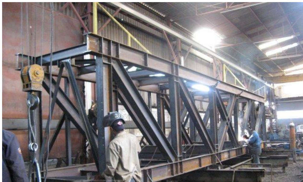
Figura 4.3.1 Fabricación de estructura en taller
