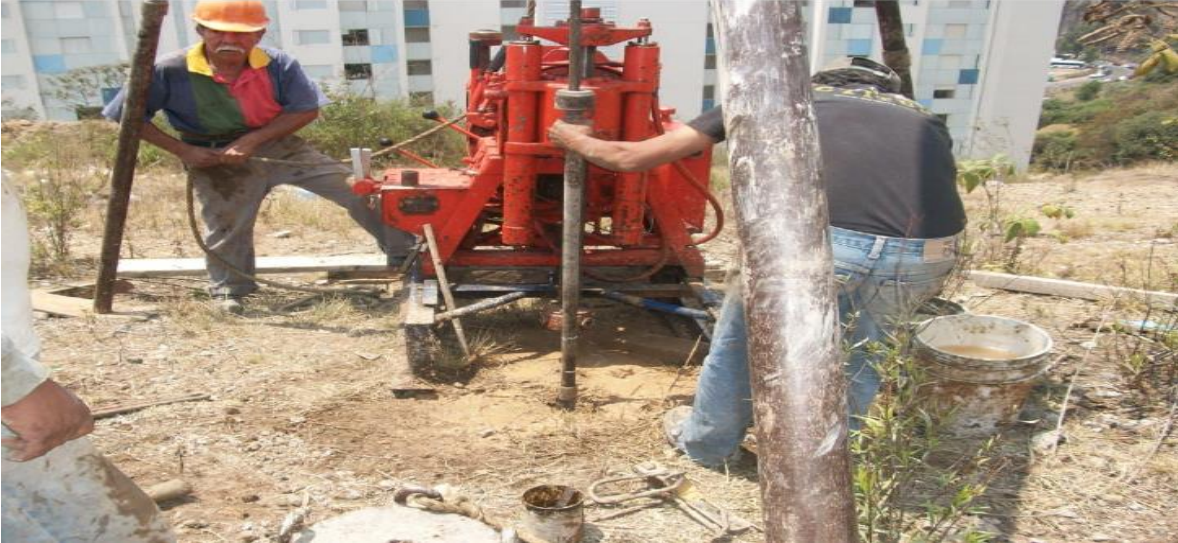
Fig. 1.10 Sondeo de Penetración Estándar.
