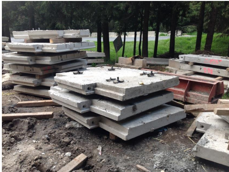
Fig. 5.24 Acopio de los Paneles de Concreto en obra
