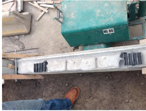
Fig.5.18 Neoprenos colocados en el panel de concreto
