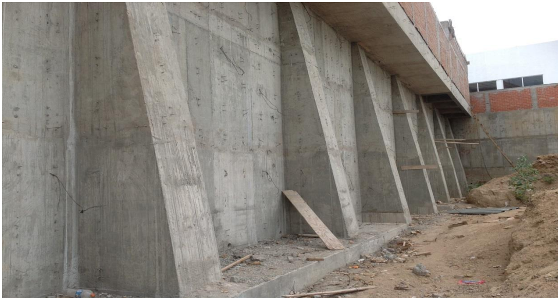
Fig. 1.6 Muro con contrafuertes colindancia sur
