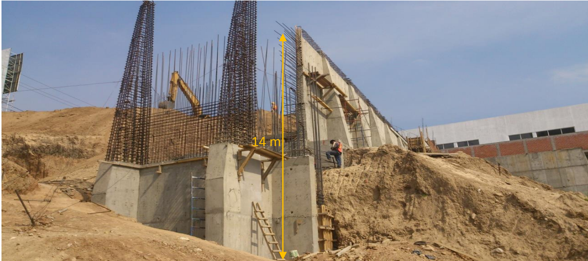
Fig. 1.6 Desplante del muro sur de concreto reforzado con contrafuertes.
