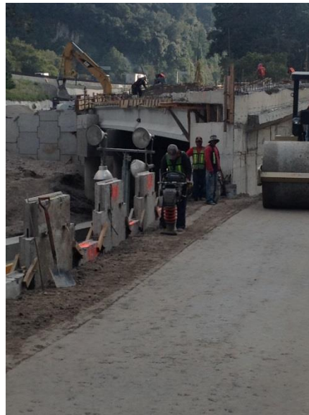
Fig.5.28 Compactación del relleno con Bailarina y Rodillo Liso Vibratorio
