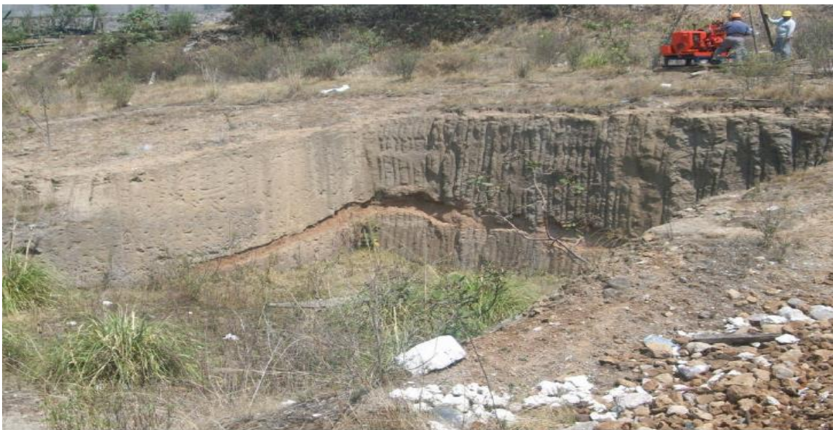
Fig. 1.3 Corte existente en el sitio de estudio
