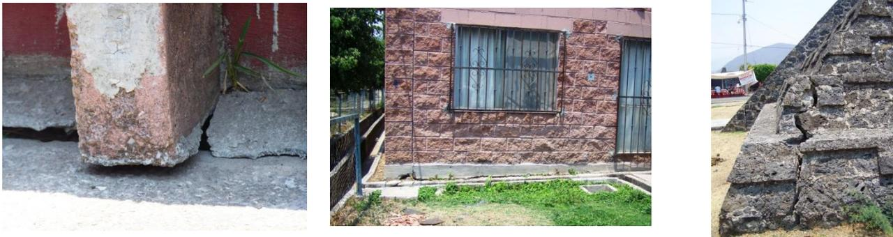
**Imagen I.3. Daños debido a las arcillas expansivas. Morelos, México. Daños tales como levantamientos de losas y grietas en estructuras.**
