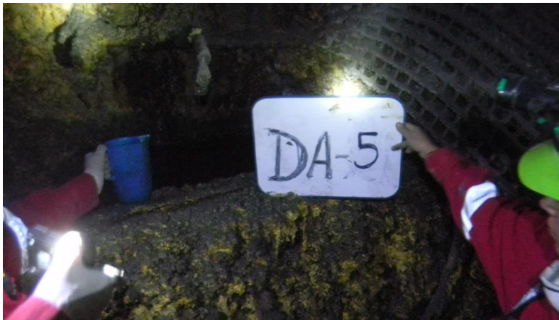
Figura 33. DA-5. Rampa Sur
