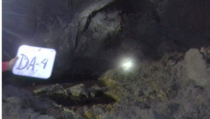
Figura 32. DA-4. Rampa Sur
