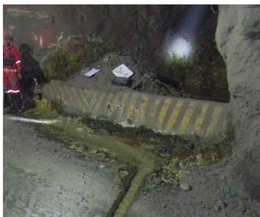
Figura 40. Uso de muro de concreto
