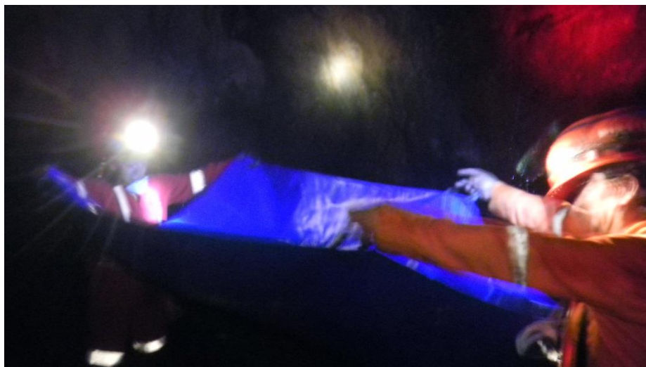
Figura 56. Uso de la lona como medio para captar los escurrimientos del cielo de las obras y contrapozos.
