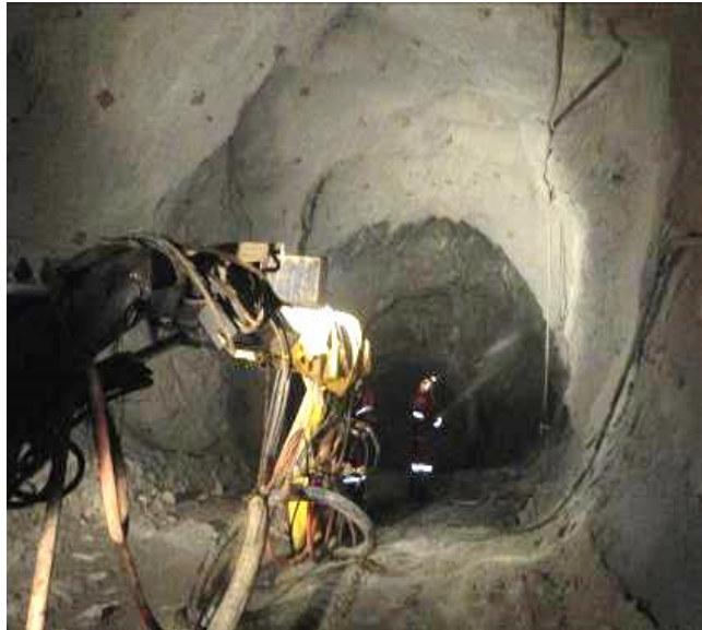
Figura 8. Zarpeo de las obras en la mina Tizapa
