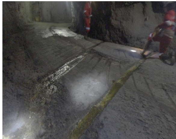
Figura 43. Canaletas sobre la rampa Sur
