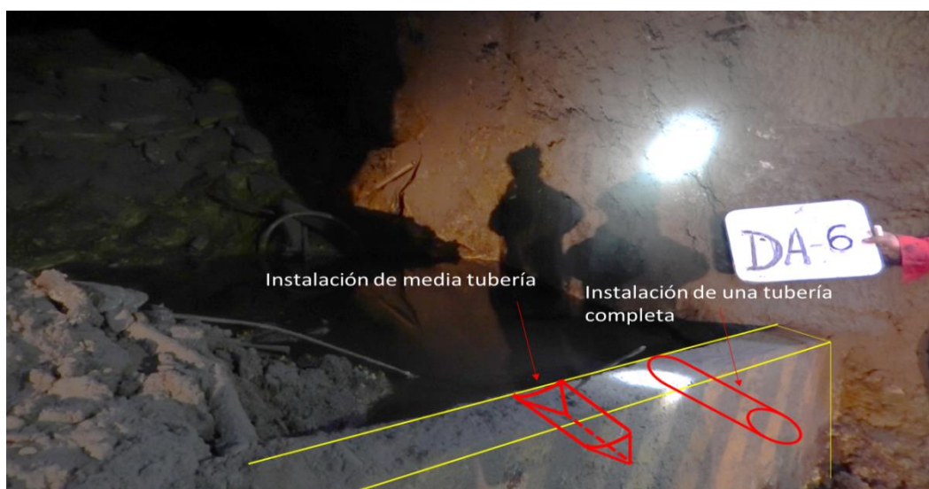
Figura 63. Acondicionamiento de los muros para realizar una medición más eficiente
