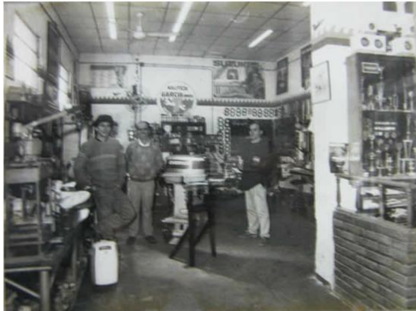
Taller mecánico o centro de servicio marino
