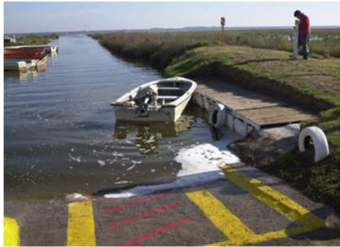
Rampa o botadero de embarcaciones
