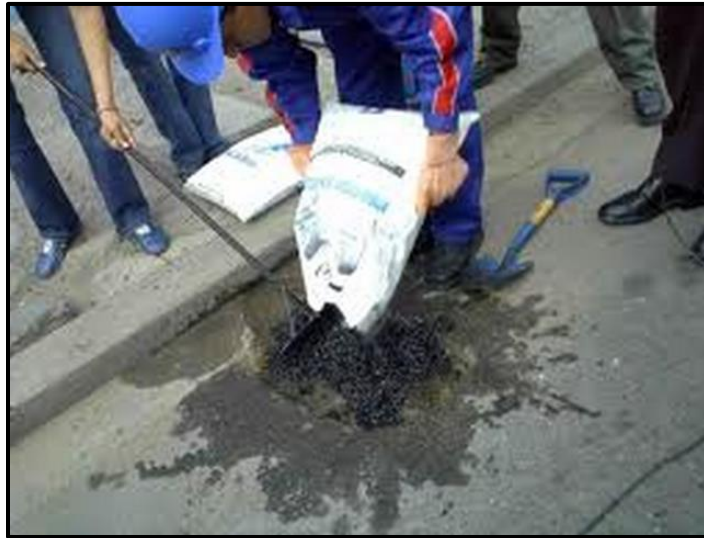
Figura 2-7 Reparación de bache con mezcla asfáltica fría
