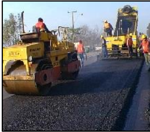
Figura 2-2 Colocación de mezcla asfáltica en caliente
