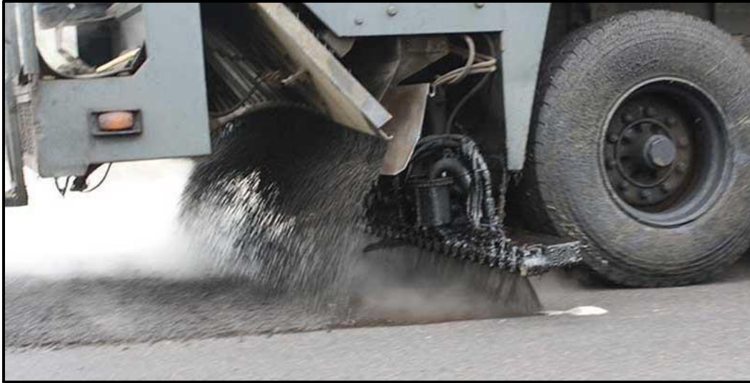
Figura 2-9 Riego de sello en una carpeta ya existente
