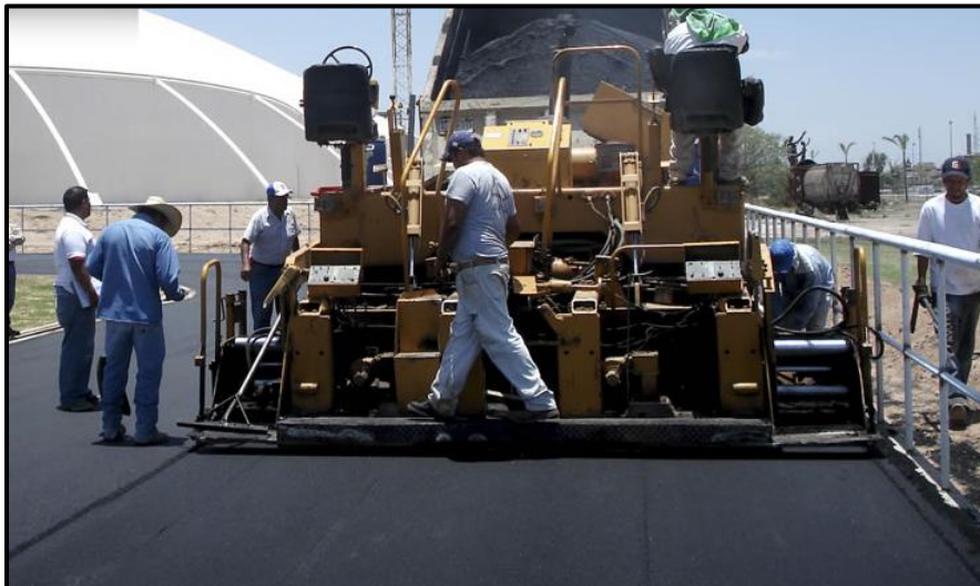
Figura 2-8 Colocación de mortero asfáltico
