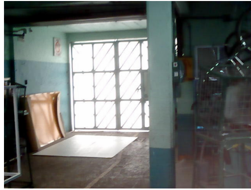
Fotografía 11.- Estirenos sin pegar en el piso
