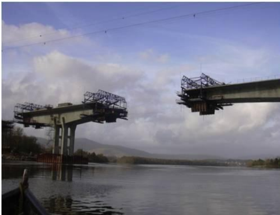
Figura 7 Puente de la amistad, frontera internacional
