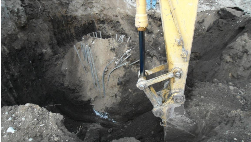
Figura 33 Descubrimiento de Pilotes
