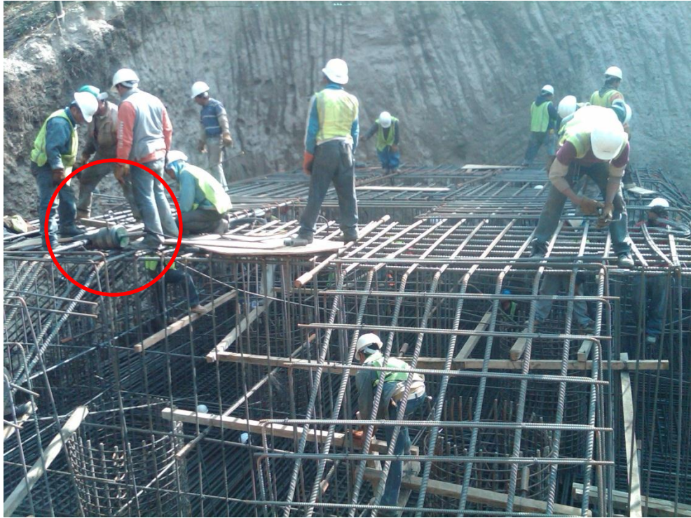
Figura 35 Personal técnico colocando conectores extruidos
