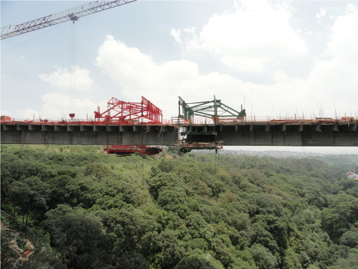
Figura 59 Dovela de cierre claro 2 por colar
