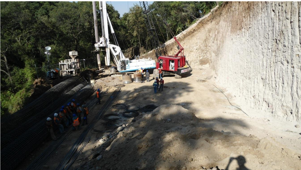
Figura 32 Pilotes en Pila 3
