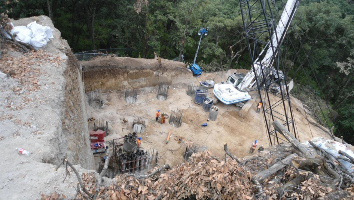
Figura 31 Pilotes en Pila 2
