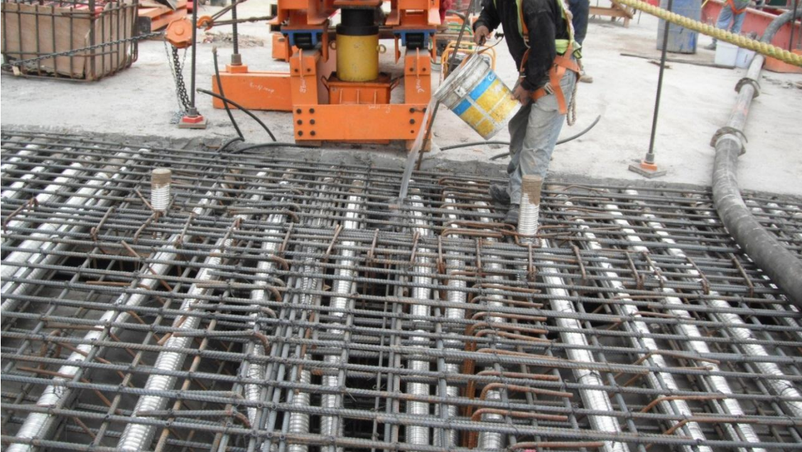
Figura 67 Ductos dentro de armado de acero
