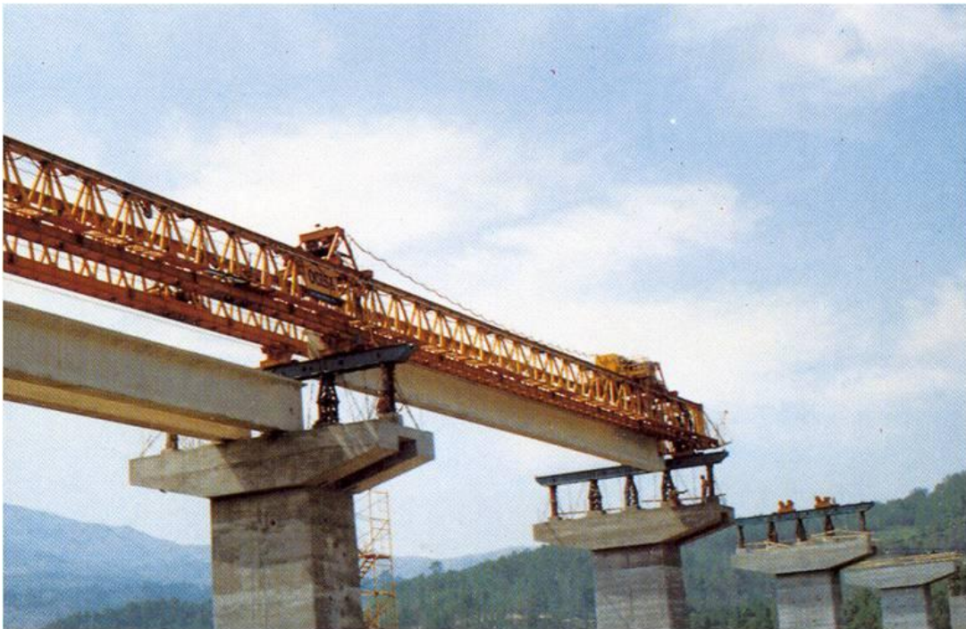
Figura 5 Lanzadora de trabe en fase de descenso
