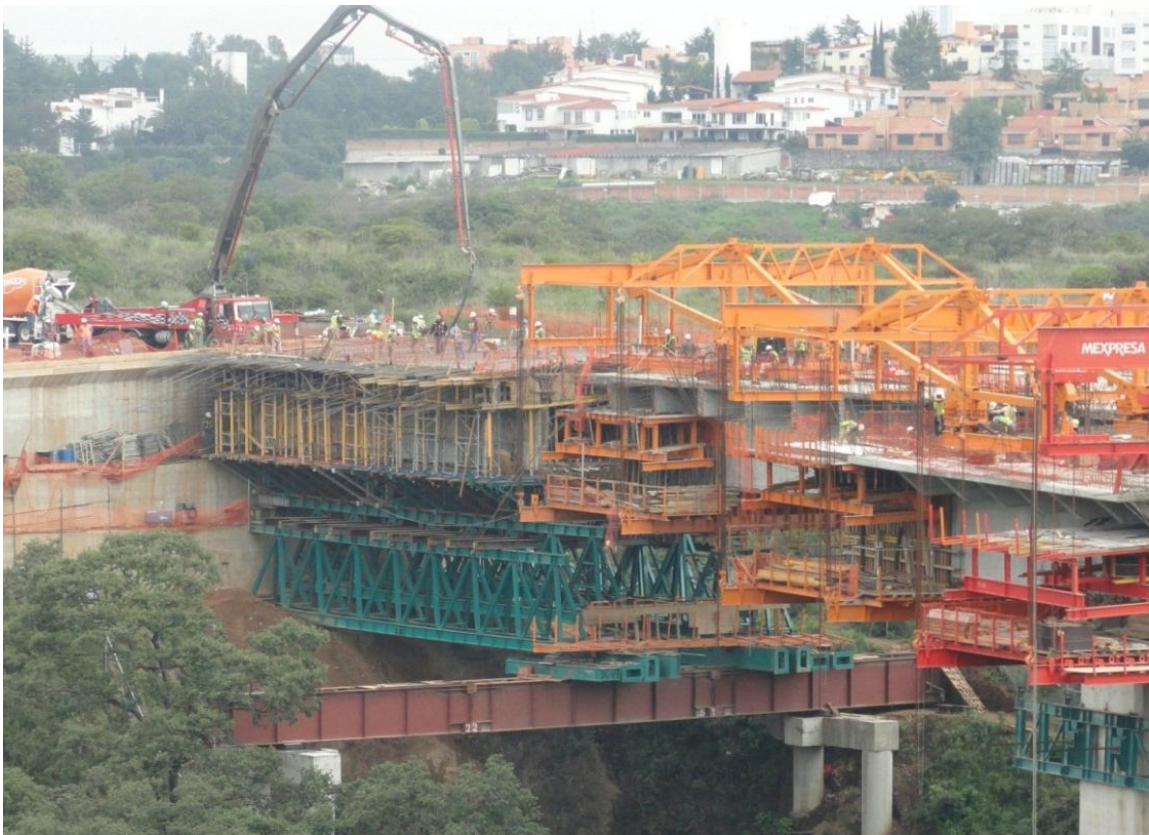
Figura 63 Conjunto de Obra Falsa
