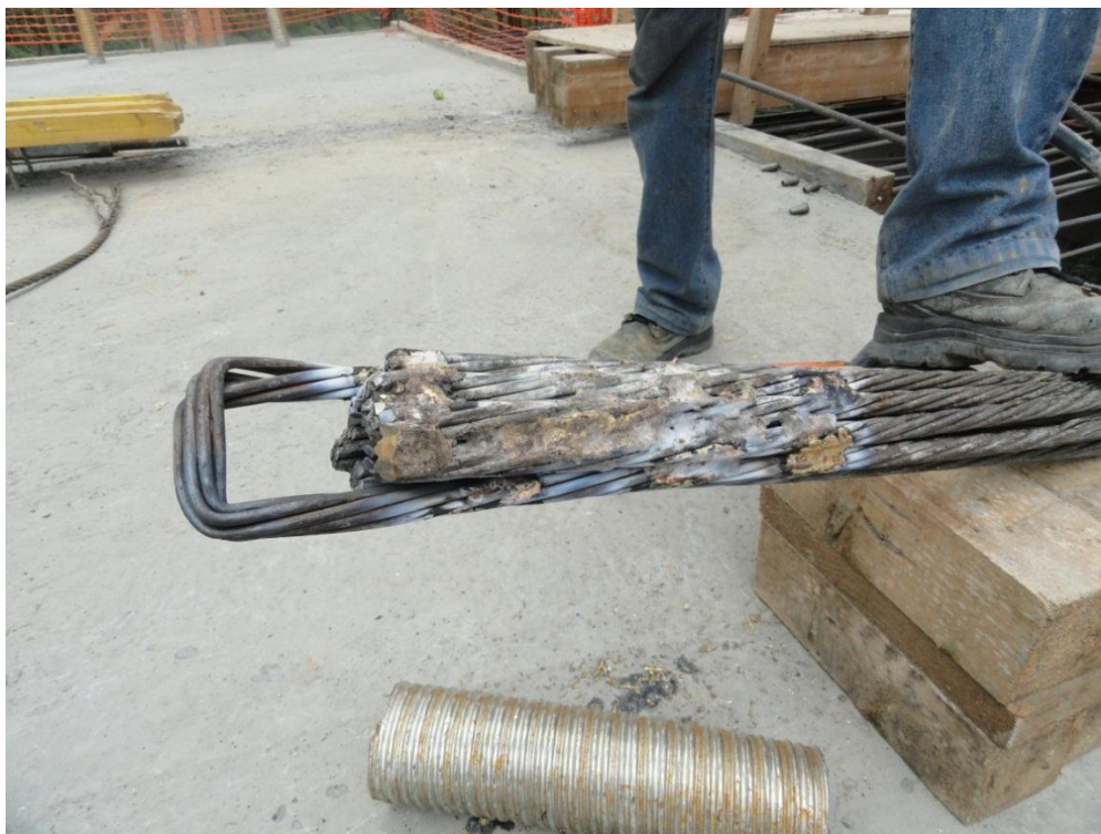
Figura 68 Paquete de torones por insertar en el ducto
