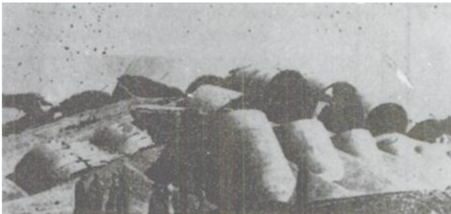
Fig. 6.28 Estado en que quedó el silo de Fargo, Dakota del Norte al fallar la cimentación. Tomado de Ref. 5 “Silos”
