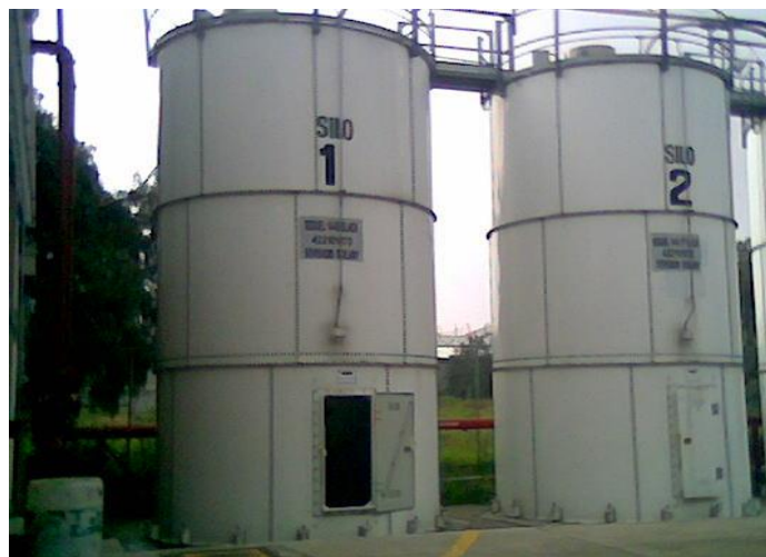
Fig. 2.5 Silos metálicos atornillables de chapa lisa “cortesía de TASIJP”
