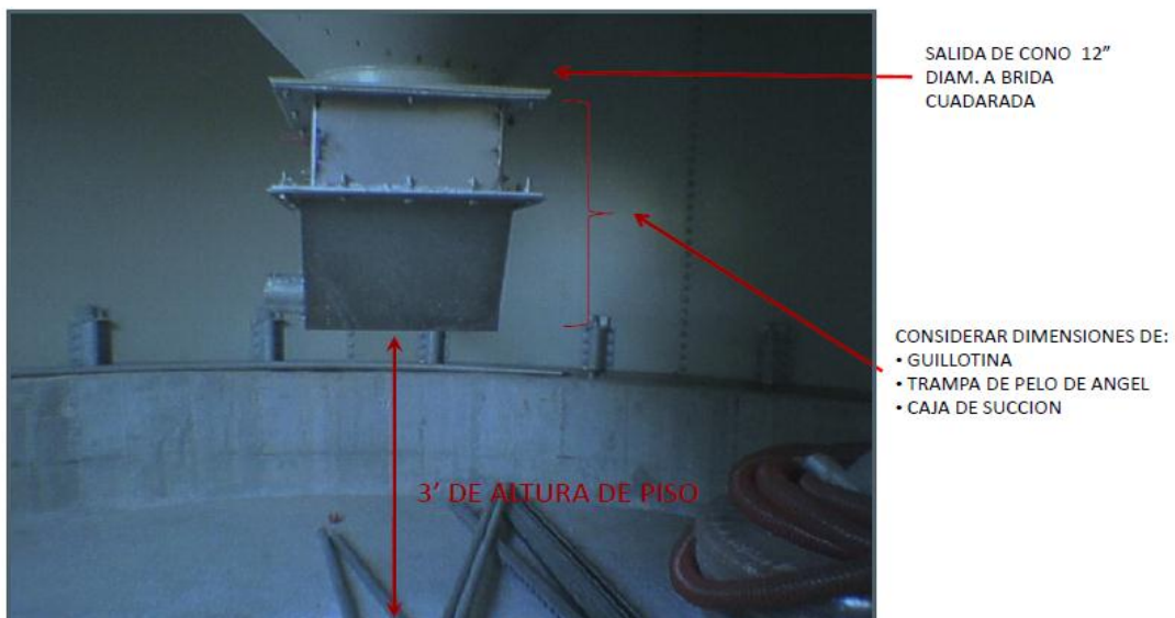
Fig. 5.2 Interior de un silo metálico apoyado en cimentación circular, cortesía TASIJI
