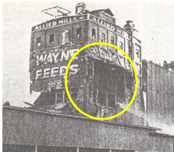
Fig. 3.7 Explosión en silo para harinas en Memphis, Tennessee (USA). Tomado de Ref. 5 “Silos”
