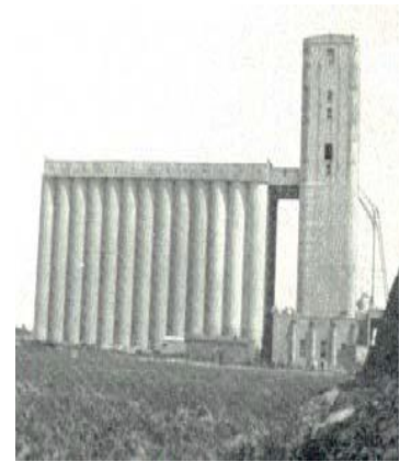
Fig. 6.1 Silos de Transcona, Canadá recién terminados en 1913
