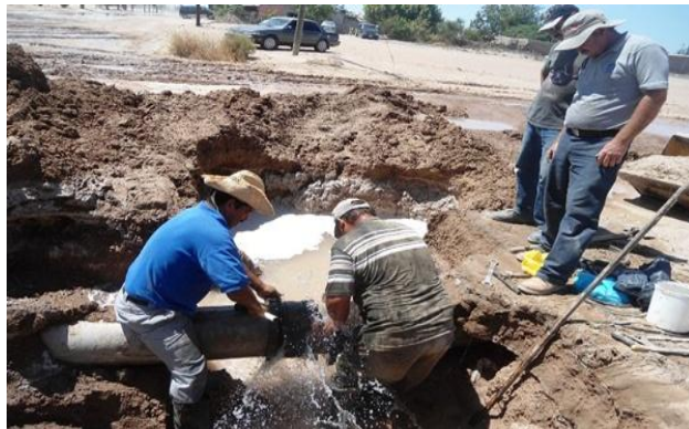
Figura 3.10 Reparación de fugas
