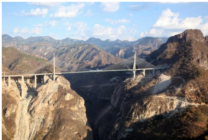
Figura 5.4 Puente Baluarte Sinaloa México. Cimentación de columnas sobre roca [im5.4]
