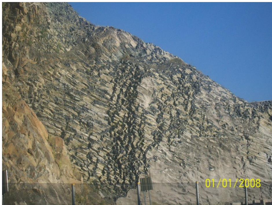
Figura 4.12 Macizo claramente anisótropo al presentar un solo plano de discontinuidad
