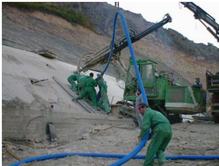
Figura 3.1 Inyección en roca [im3.1]
