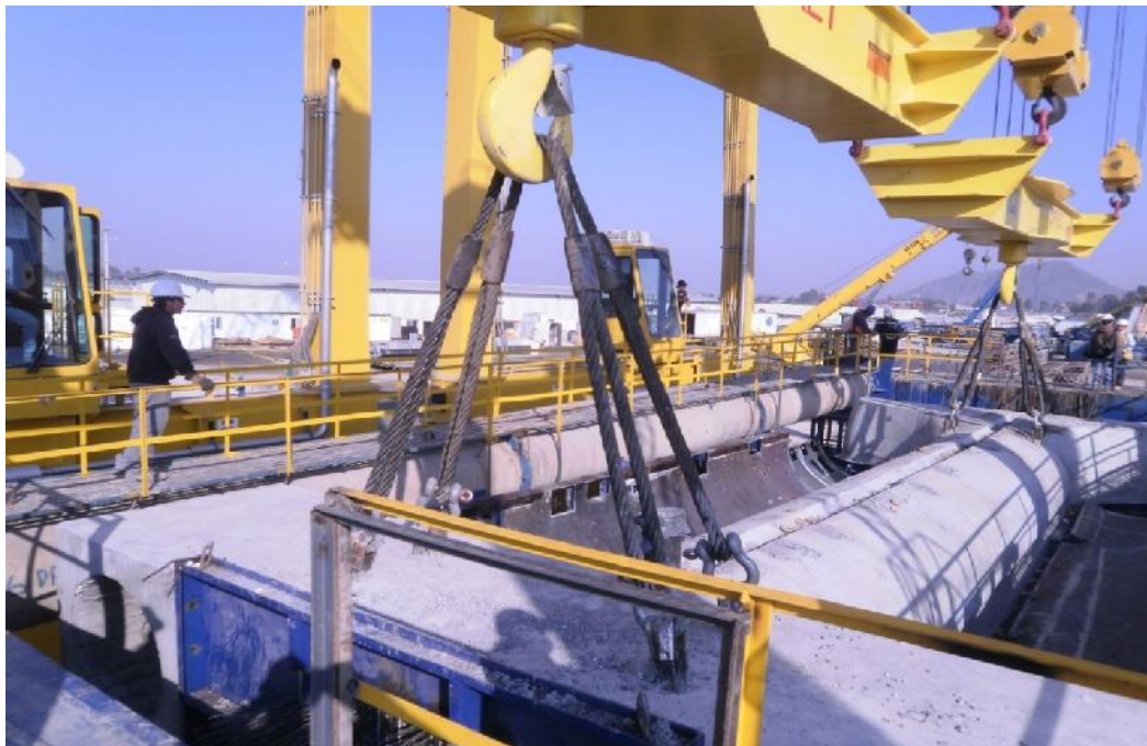
Ilustración 46. “Transporte con grúa dentro de la planta”
