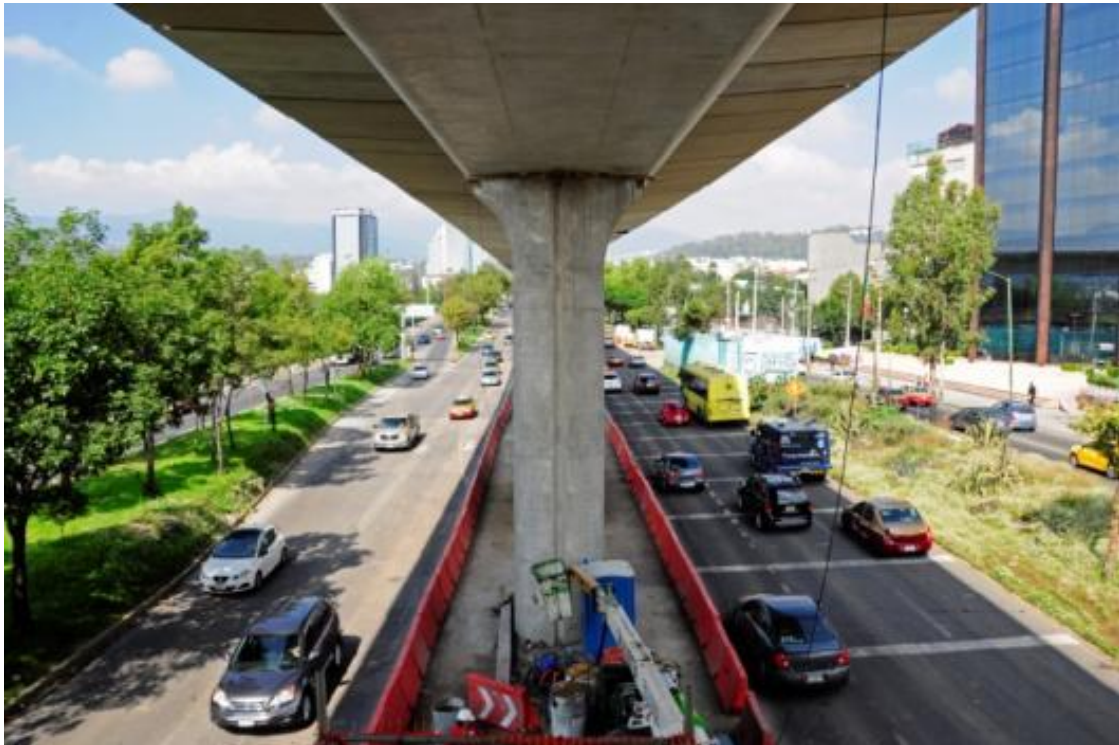
Ilustración 29. “Conexión Zacatepetl vista inferior”
