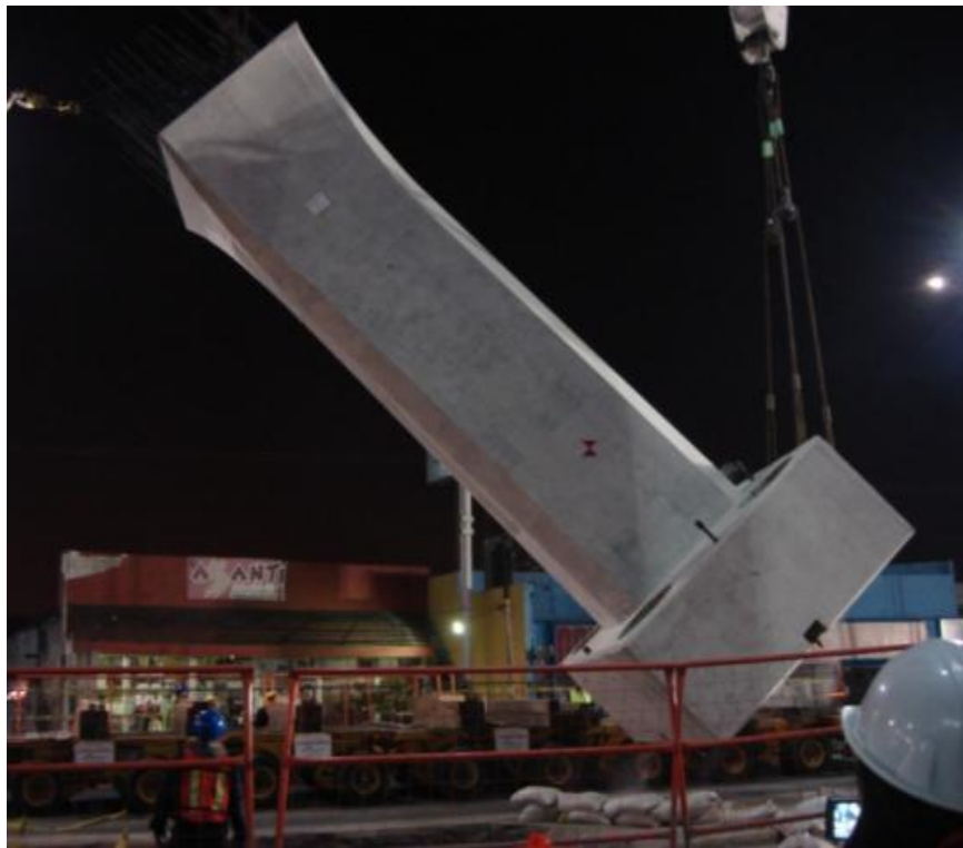
Ilustración 62. "Montaje de columna"
