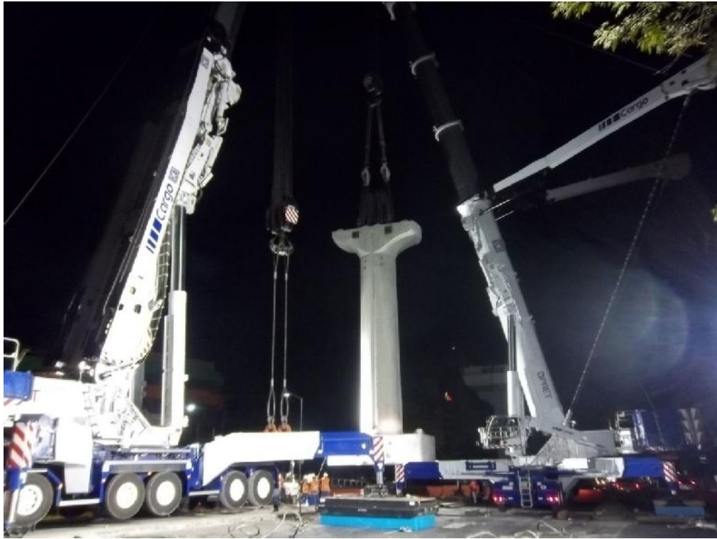
Ilustración 64. “Montaje de columna para 4 carriles”
