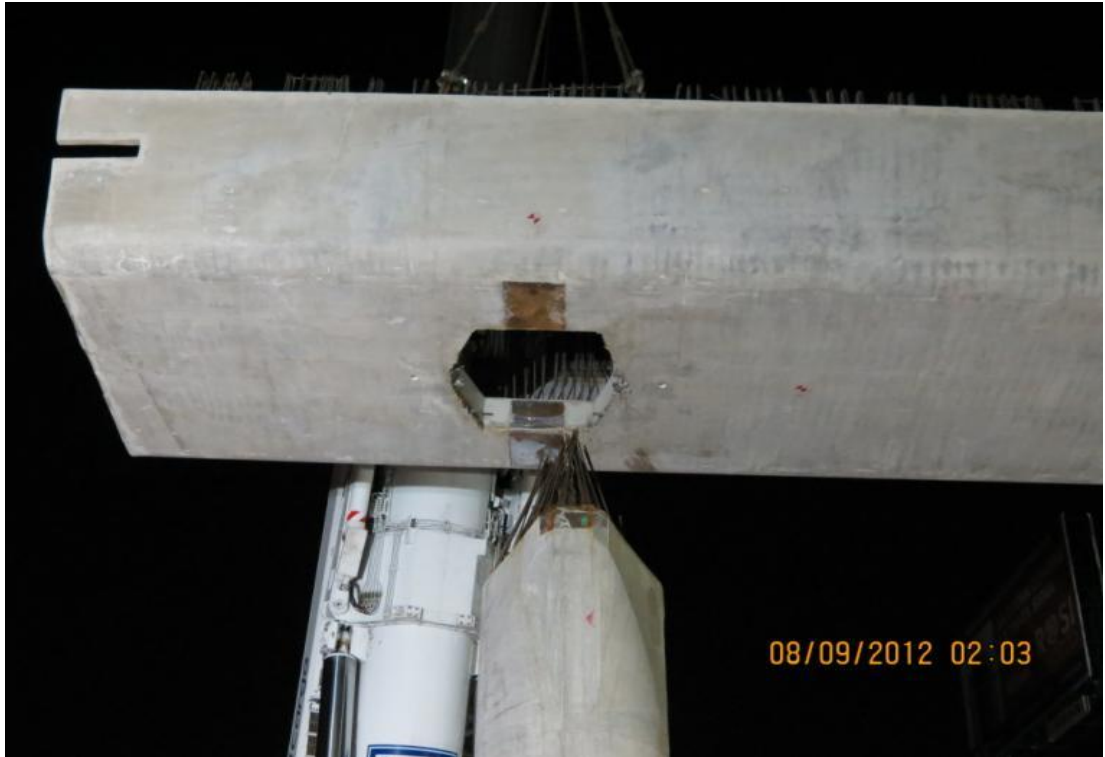
Ilustración 66. "Montaje de trabe en columna"
