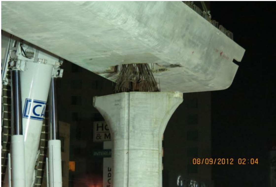
Ilustración 68. “Montaje de trabe en columna”
