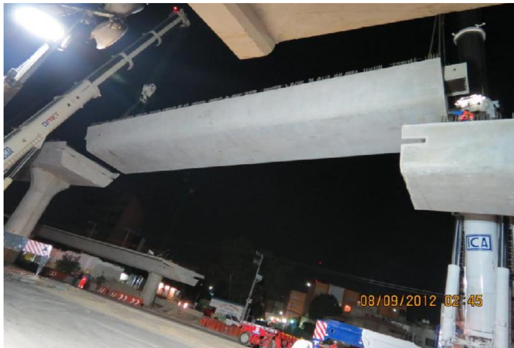
Ilustración 70. “Montaje de trabe de conexión”
