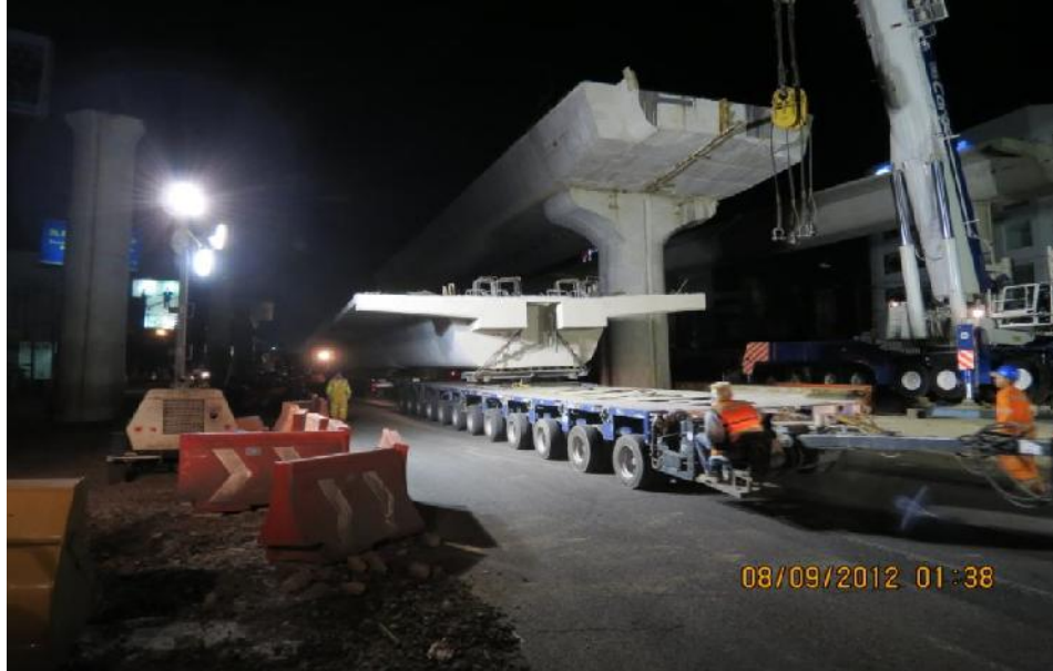
Ilustración 58. “Llegada de trabe a sitio de montaje”
