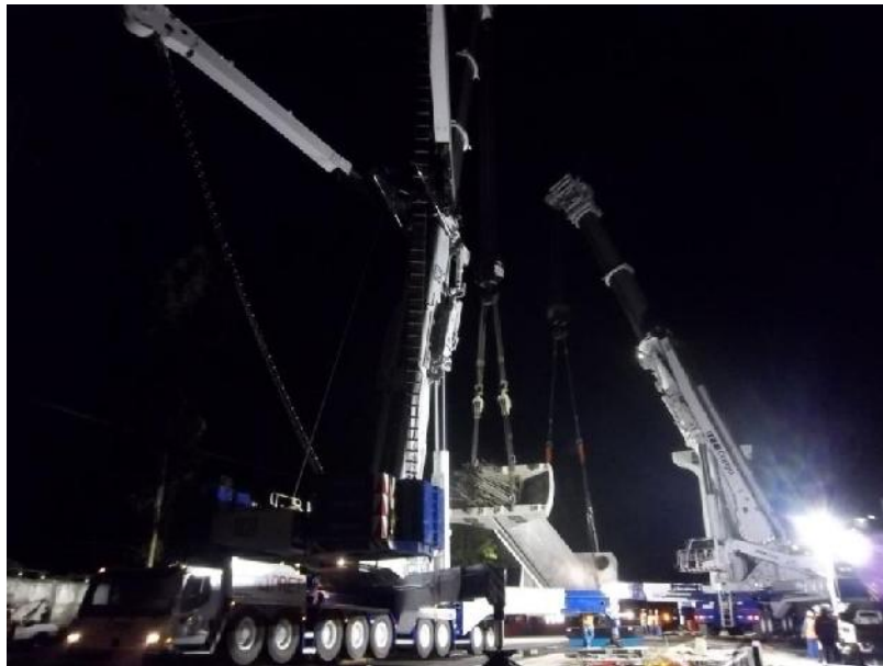
Ilustración 61. "Montaje de columna"
