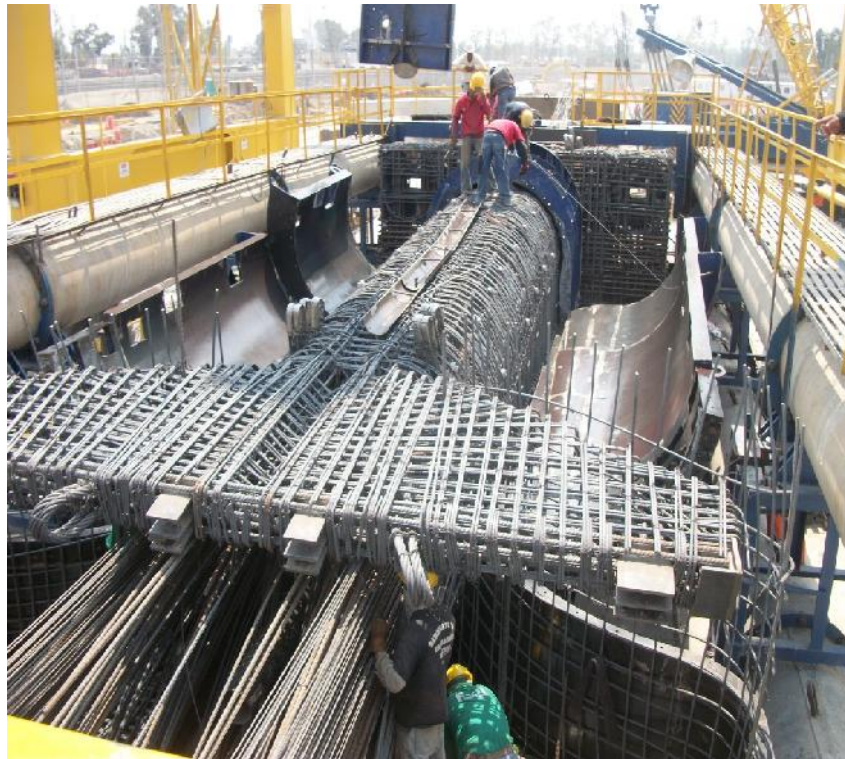
Ilustración 39. "Armado de Columna"
