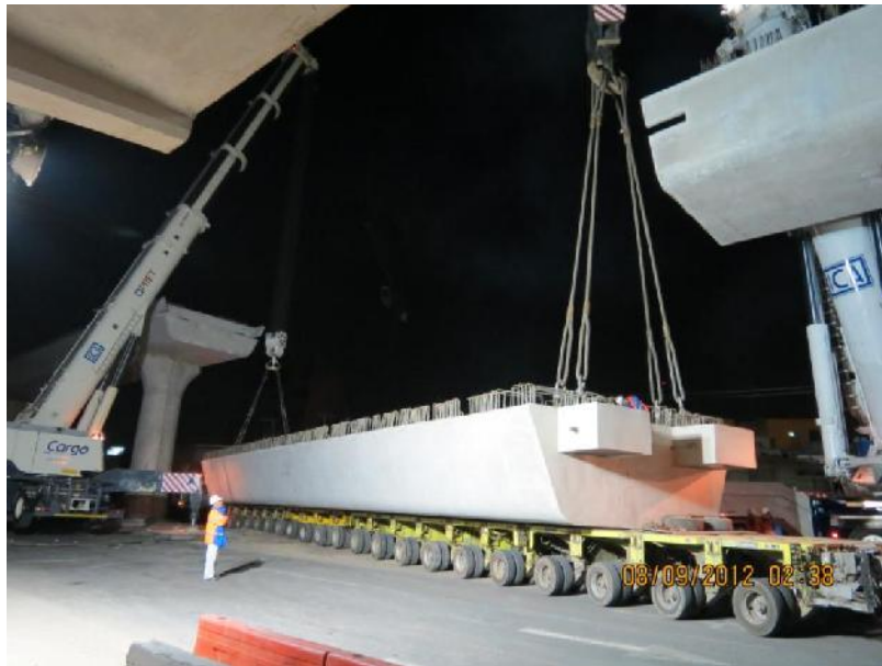
Ilustración 59. “Grúas de 1200tons listas para elevar elemento”
