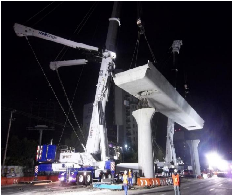
Ilustración 65. "Montaje de travesa en columnas"
