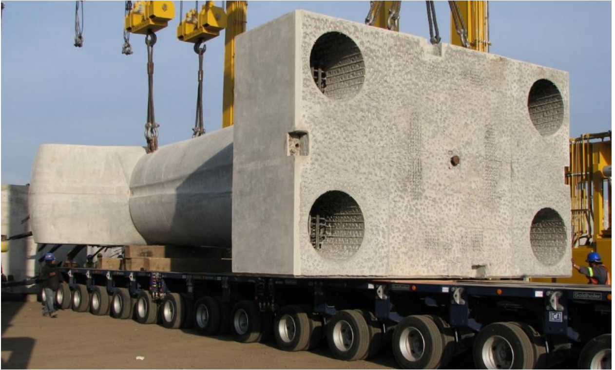
Ilustración 41. "Montaje de Columna en modular para transporte"
