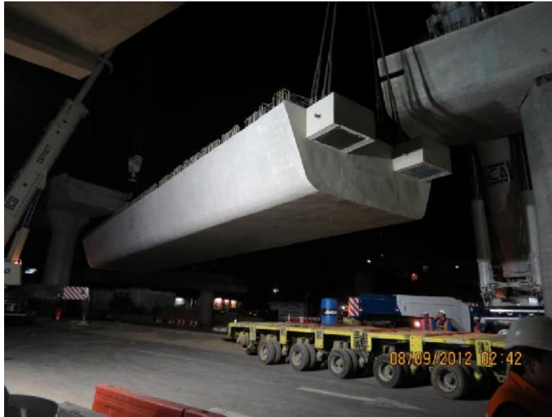
Ilustración 60. "Montaje de trabe"
