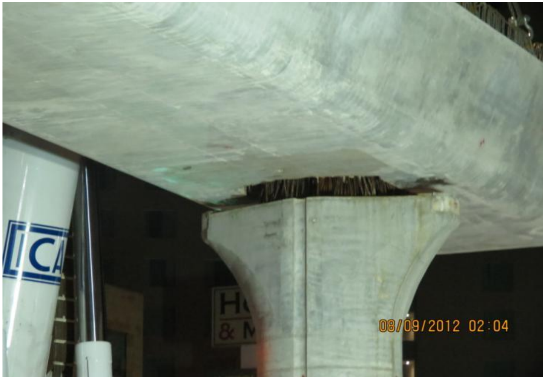
Ilustración 67. "Montaje de Trabe en columna"
