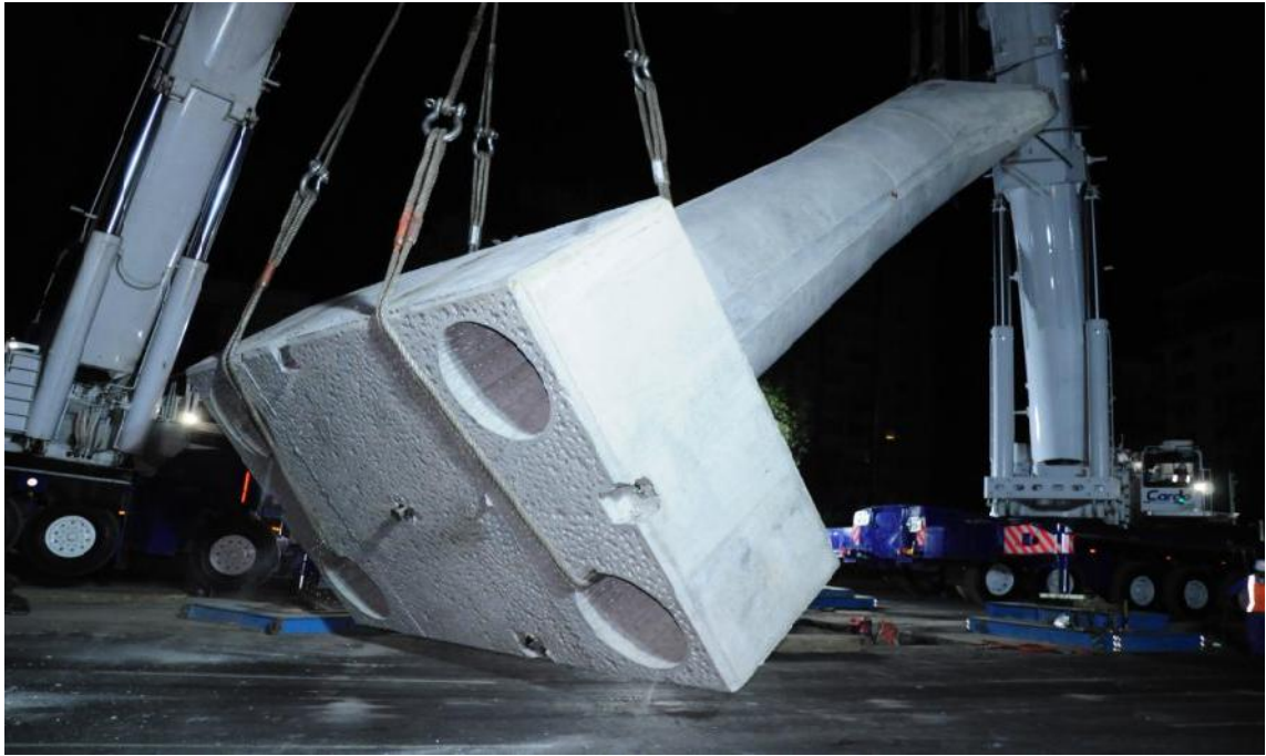
Ilustración 63. “Montaje de Columna”
