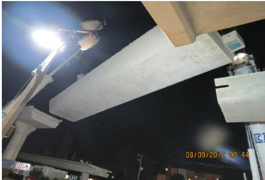
Ilustración 69. “Montaje de trabe de conexión”
