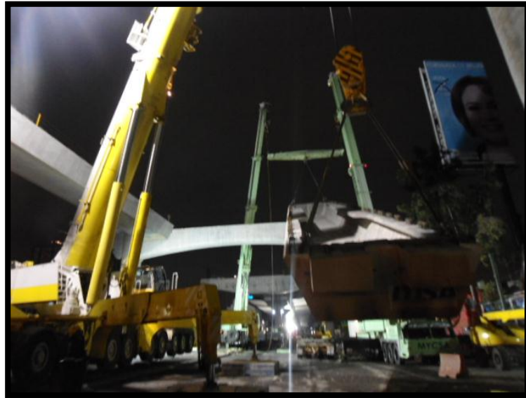
Imagen 48 LEVANTAMIENTO DE TRABE
