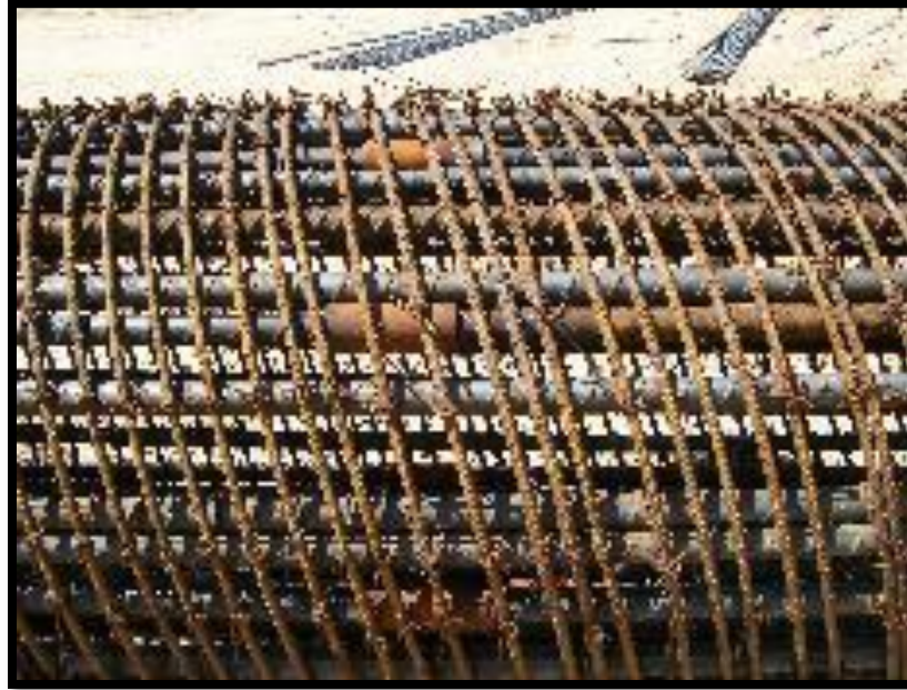
Imagen 22 ARMADO DE PILAS
