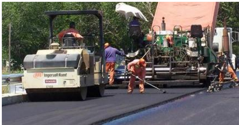
Imagen 61 COLOCACIÓN DE PAVIMENTO ASFÁLTICO
