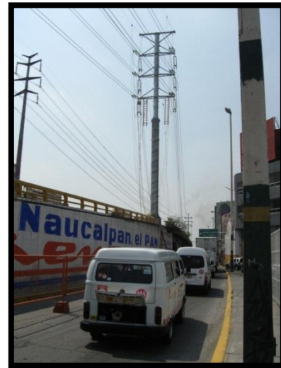
Imagen 6 LEVANTAMIENTO DE CABLES TERMINADO
