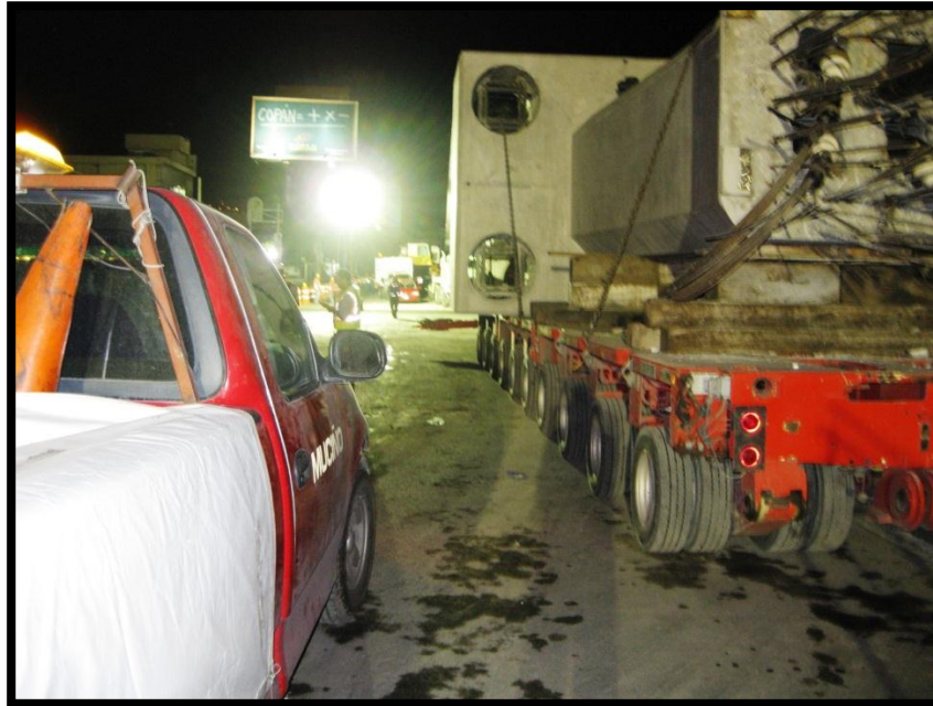
Imagen 35 LLEGADA DE ZAPATA COLUMNA A OBRA
