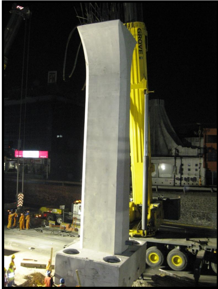
Imagen 39 LEVANTAMIENTO CON UNA SOLA GRÚA
