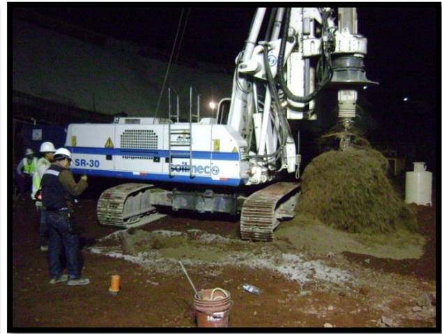
Imagen 20 PERFORACIÓN EN OBRA
