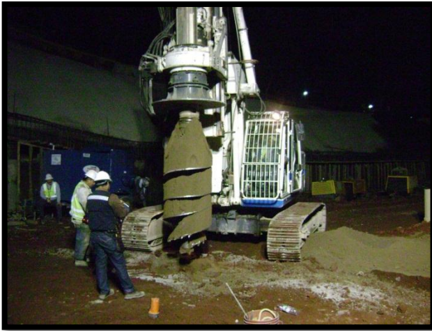
Imagen 21 EQUIPO DE PERFORACIÓN Y BROCAS
