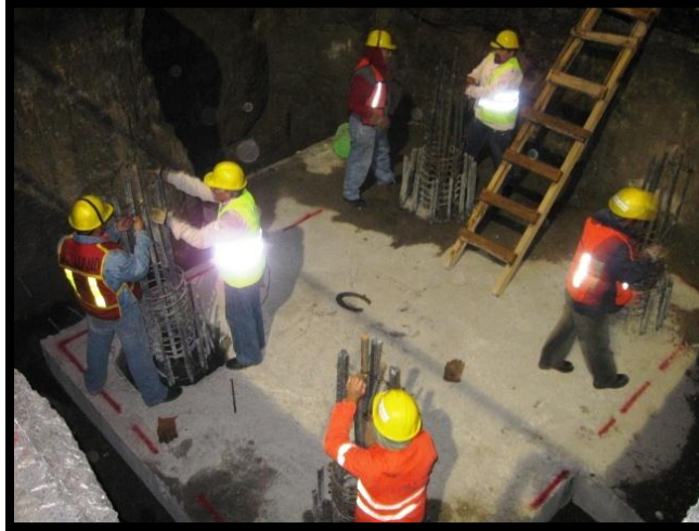
Imagen 19 CONSTRUCCIÓN DE ZAPATAS
