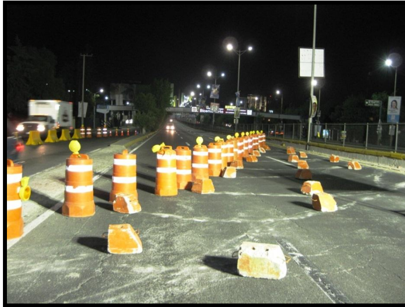
Imagen 16 CIERRES NOCTURNOS EN VÍAS PARA CONSTRUCCIÓN DE OBRAS
