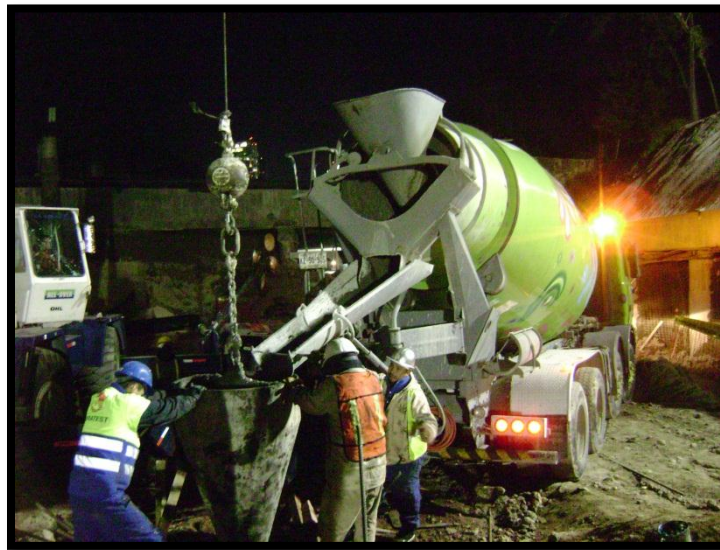
Imagen 26 COLADO DE PILA
