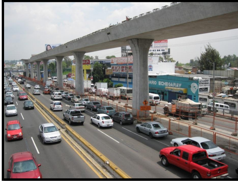
Imagen 17 ENMALLADO DE OBRA PARA TRABAJOS EN EL DÍA
