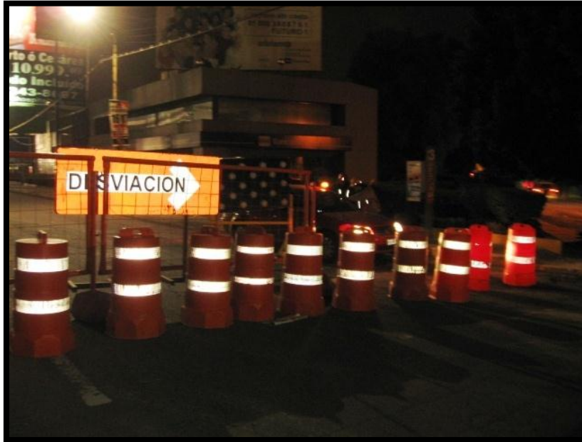
Imagen 18 CIERRES CON TRAFITAMBOS, MALLAS Y SEÑALIZACIÓN ILUMINADA
