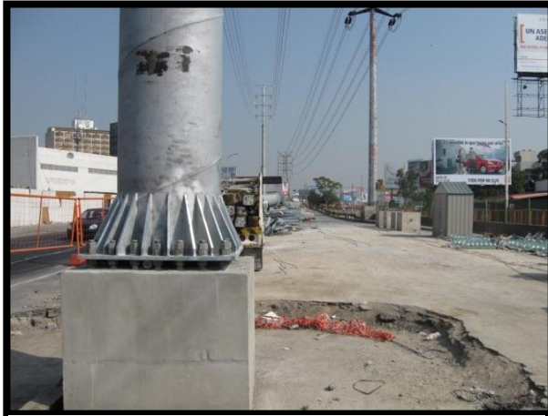
Imagen 4 CONEXIÓN DE CABLES ALTA TENSIÓN POR PERSONAL DE CFE
