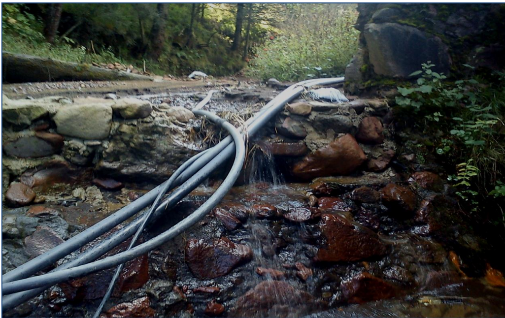
Figura IV-3.-Aliviadero de los Apapaxtles. Fuente: Propia
