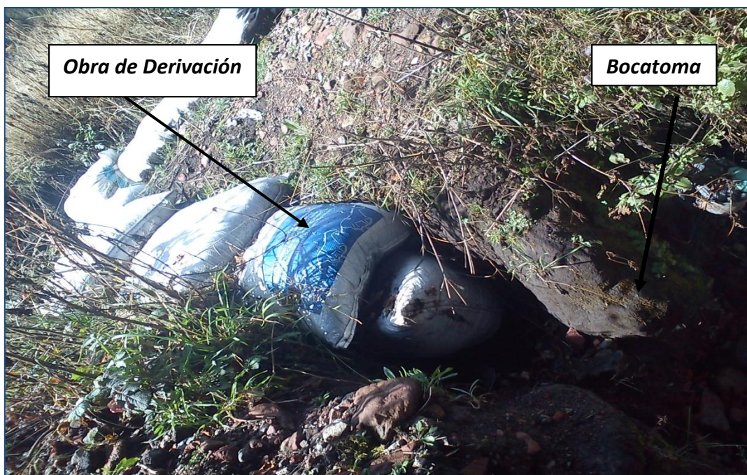
Figura IV-1.-Obra de derivación y Bocatoma en los Apapaxtles. Fuente: Propia
