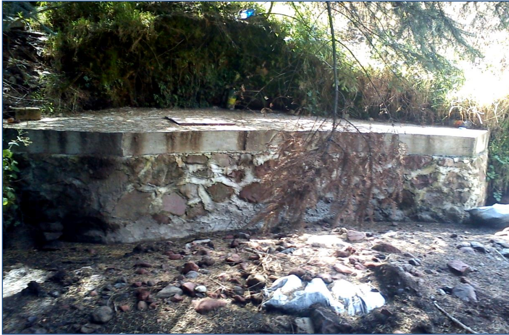
Figura IV-4.-Cámara de carga de los Apapaxtles. Fuente: propia
