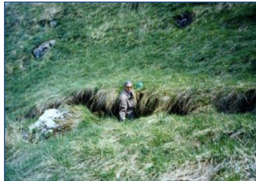
Figura II-10.- Canal de derivación a Cielo Abierto Fuente: Comisión Europea, (1998) Manual para una pequeña hidráulica.
