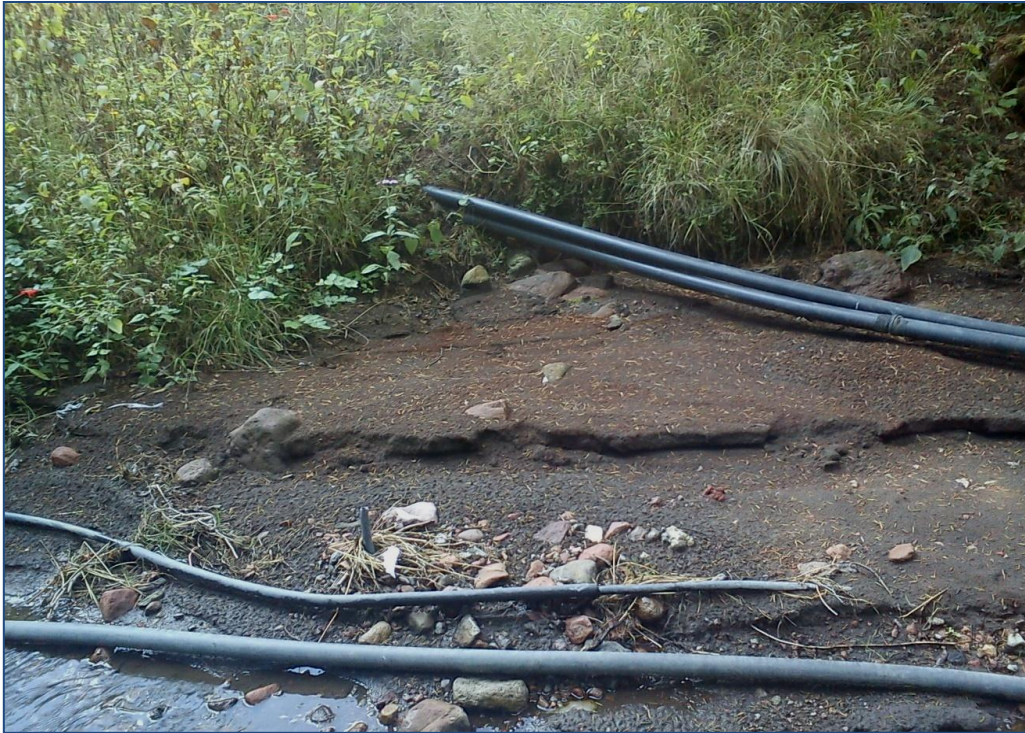
Figura IV-5.-Tubería de los Apapaxtles. Fuente: propia
