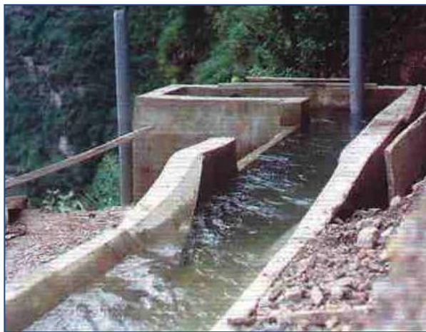
Figura II-5.- Ejemplo de un Desarenador Fuente: Ramírez et al, (2004), Micro Central hidroeléctrica una alternativa para el desarrollo rural.
