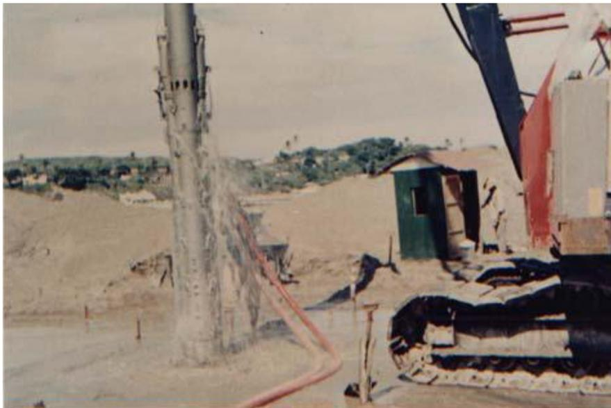
Figura 4.10 Vibrador de fondo y colocación de relleno, Alvarado, Veracruz, 1963 (cortesía Ing. Rolando Ugalde).
