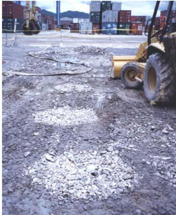
Figura 4.15 Columnas de grava.
