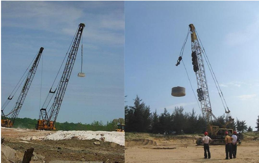
*Figura 4.1 Compactación dinámica con una grúa convencional
