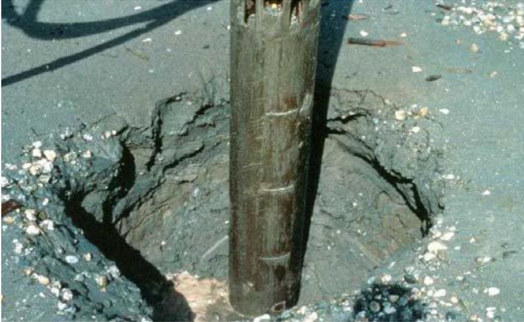
*Figura 4.7 Espacio anular alrededor del vibrador creado durante la penetración.*
