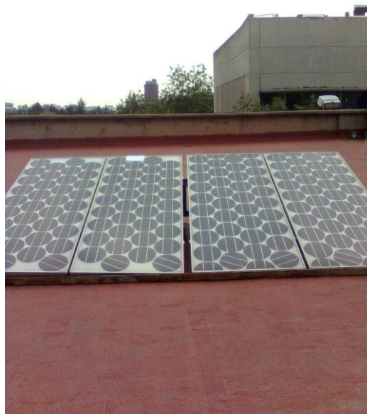
Ilustración No. 518 Instalación de los paneles FV en la azotea de la DIE
