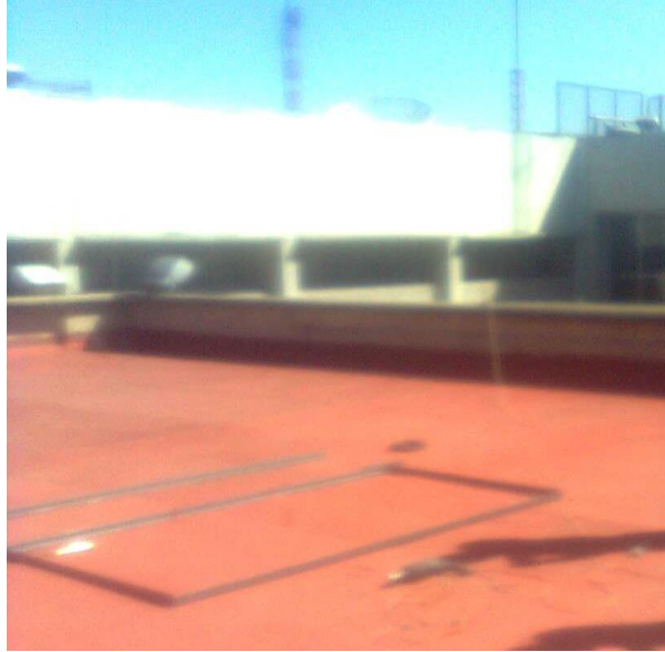
Ilustración No. 60 Base de los paneles formada de ángulo
