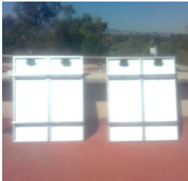
Ilustración No. 531 Colocación de los paneles por pares
