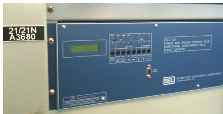
FIGURA 1.2. Fotografía donde se muestra un relevador microprocesado y a su izquierda la nomenclatura 21/21N lo cual nos indica que es una protección de distancia.
