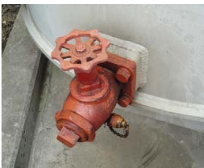
FIGURA 2.25. *Válvula de muestreo de aceite.*
