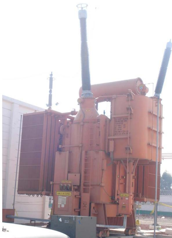
FIGURA 1.13. *Autotransformador monofásico con nomenclatura AT421C fase C de S.E. Santa Cruz (CFE).*
