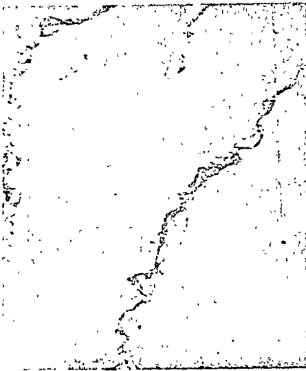
Fig. 76. Agrietamiento observado en el interior de la casa.
