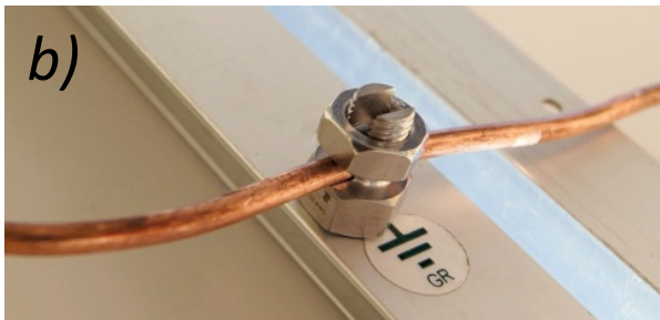
Figura 46. a) y b) Puesta a tierra de equipo. c) Caja combinadora (bornes para puesta a tierra).
