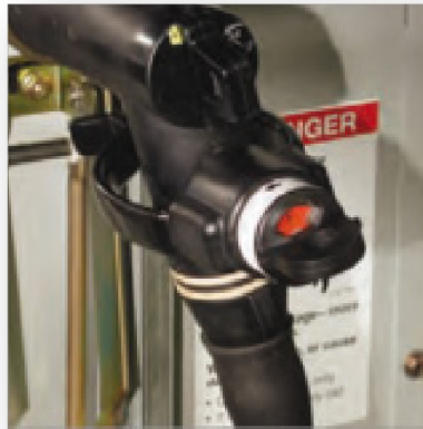
Figura 3.14 Indicador de falla, para líneas subterráneas
