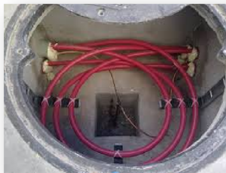
Figura 3.21 Sellado de tubería.
