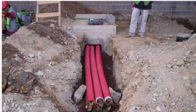
Figura 3.22 Tubo PAD de 4” para Media Tensión.
