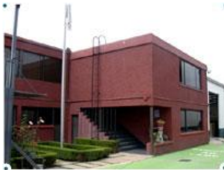
Fig. 3.- Vista de las oficinas administrativas.
