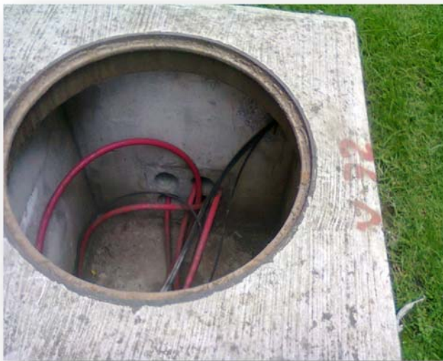
Fig.M.- Vista diagonal del registro de media tensión (Paso Cuadrado).
