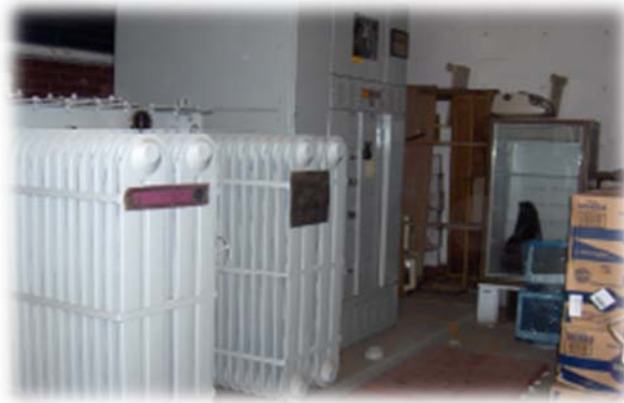
Subestación derivada utilizada como bodega.
