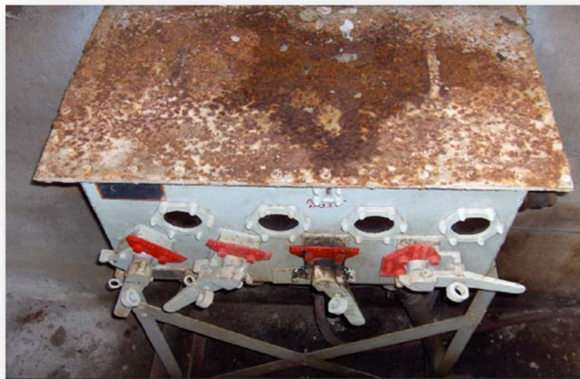
Seccionador trifásico de tres vías con aislamiento en aceite mineral.
