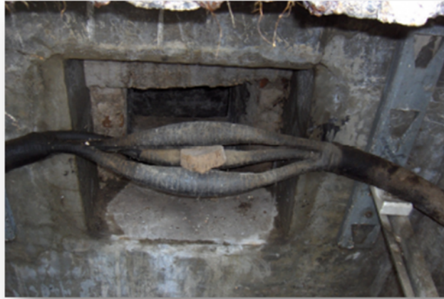
Cable tripolar con aislamiento de papel impregnado de aceite.
