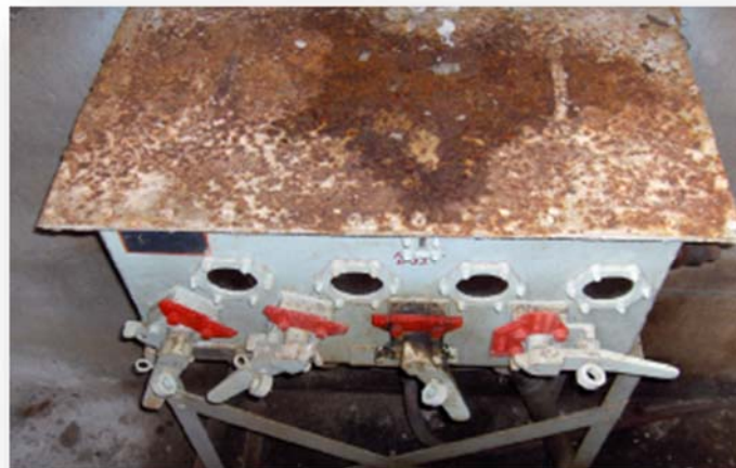
Seccionador trifásico de 3 vías con aislamiento en aceite mineral.
