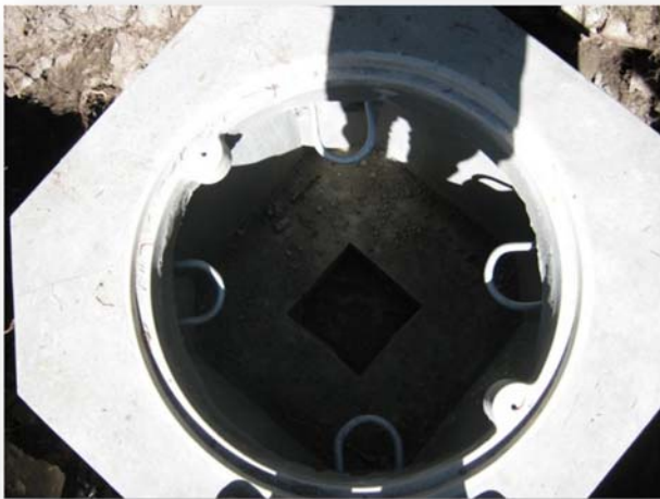
Fig.27.- Vista real del pozo de visita de media tensión, tipo L.
