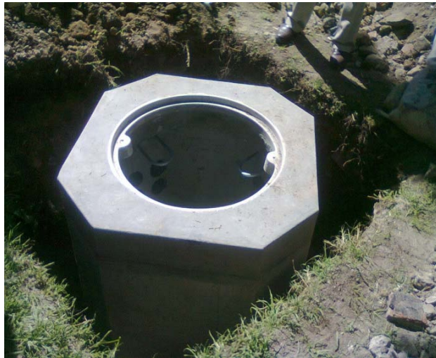
Fig.14.- Vista real del pozo de visita de media tensión, tipo X.
