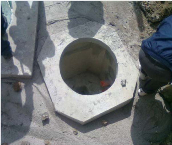
Fig.7.- Vista real del pozo de visita de media tensión, tipo P.
