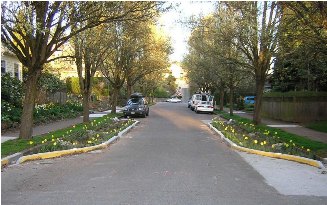
Figura 4.6 Trinchera de infiltración ubicada en banqueta (2).
