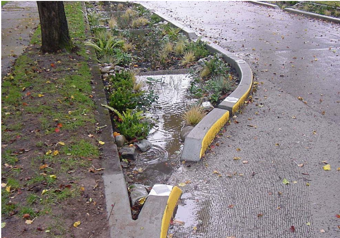
Figura 4.5 Trinchera de infiltración ubicada en banqueta (1).
