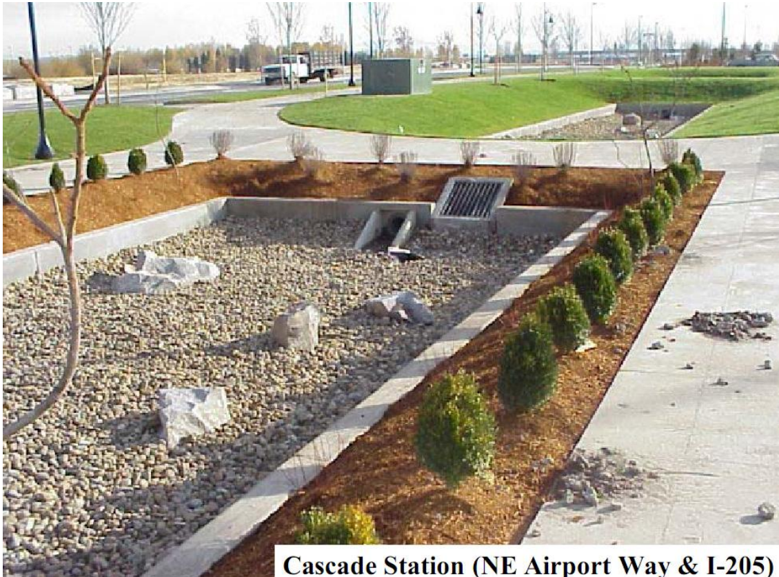
Figura 4.9 Filtro de arena como lecho de infiltración (1).
