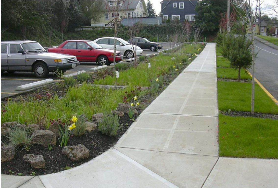
Figura 4.4 Trinchera de infiltración ubicada en un estacionamiento.
