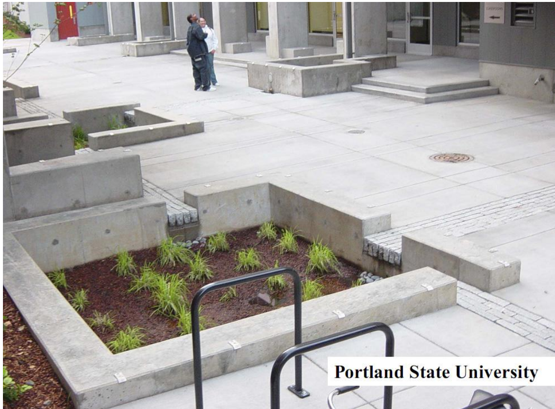
Figura 4.8 Trinchera de Infiltración habilitada como jardinera (2).
