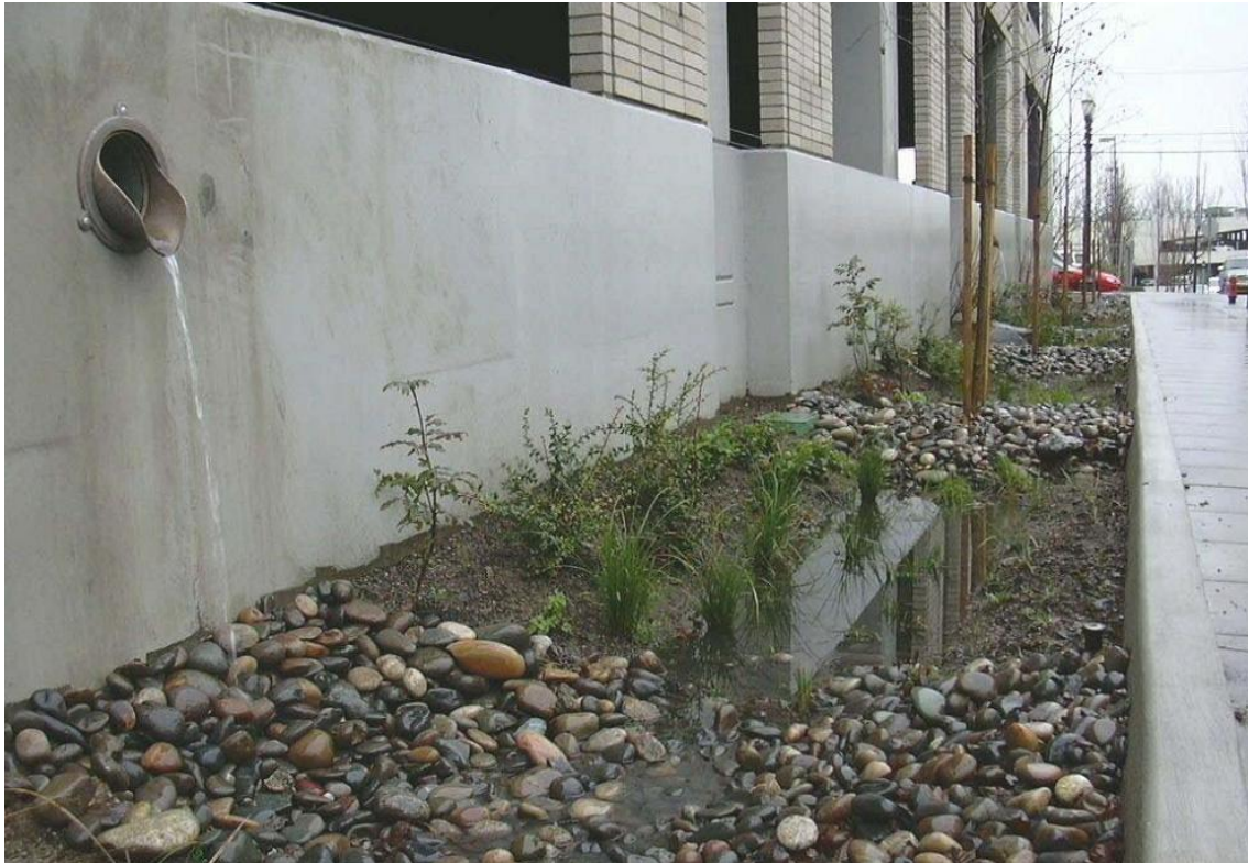
Figura 4.7 Trinchera de Infiltración habilitada como jardinera (1).
