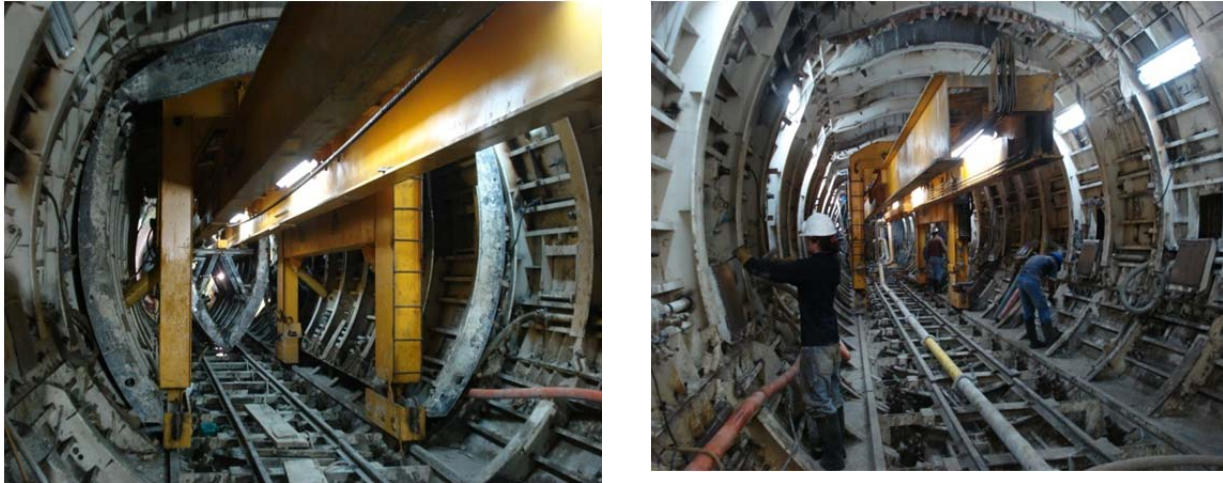
Fig. 2.5.8 Sistema transportador de la cimbra
