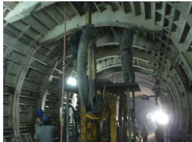
Fig. 2.5.7 Sistema electromecánico de distribución de concreto (Snorkel)
