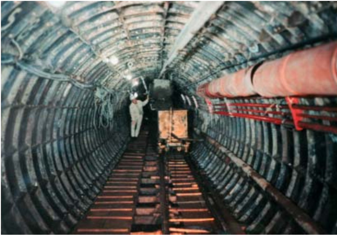
Fig. 2.3.6 Estabilizado de paredes del túnel por medio dovelas de placa metálica
