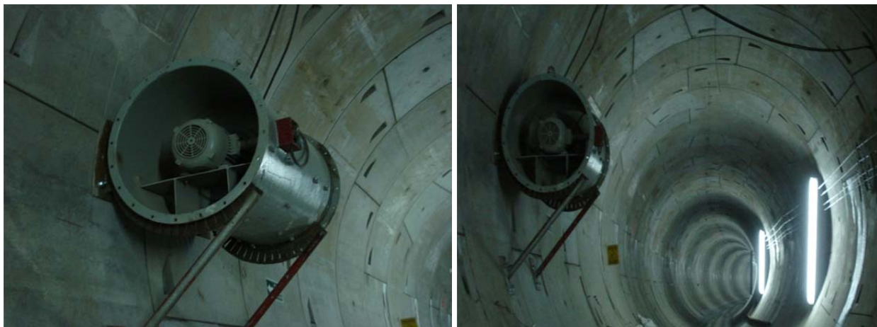
Fig. 2.4.5 Ventilación del túnel
