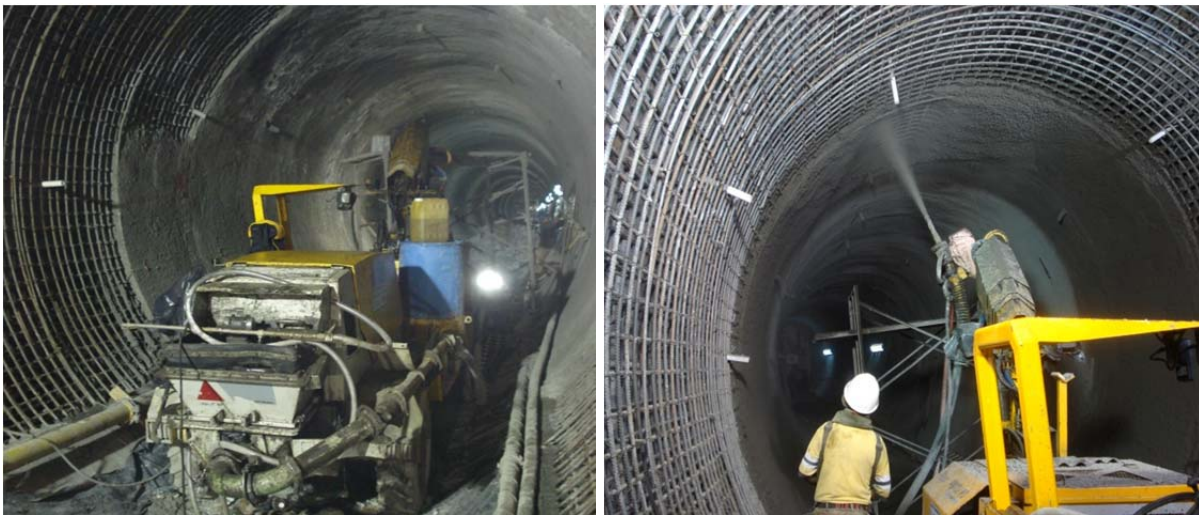
Fig. 2.5.12 Equipo para colocación de concreto lanzado
