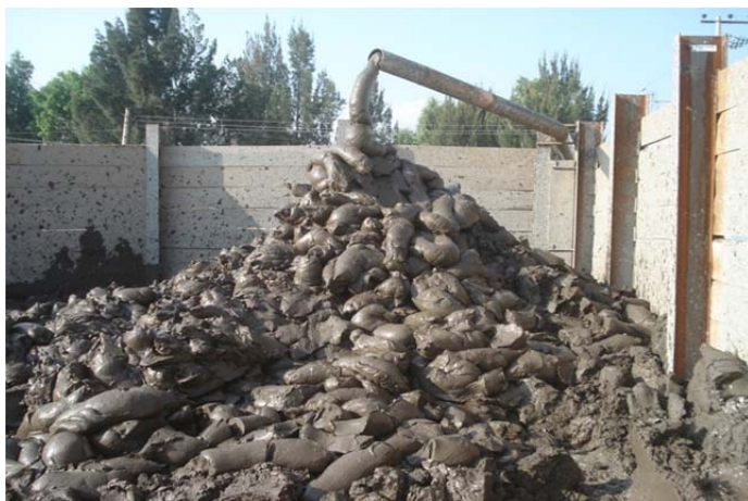
3.- Estabilización del frente Fig. 2.3.4 Material rezagado con bomba de pistón
