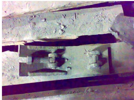
fig. 2.5.5 Vibradores para la cimbra
