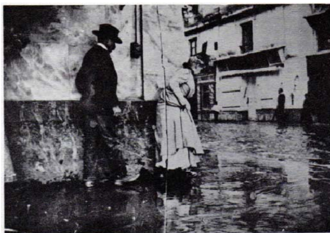
Fig. 1.3.1 Inundación en la ciudad de México
