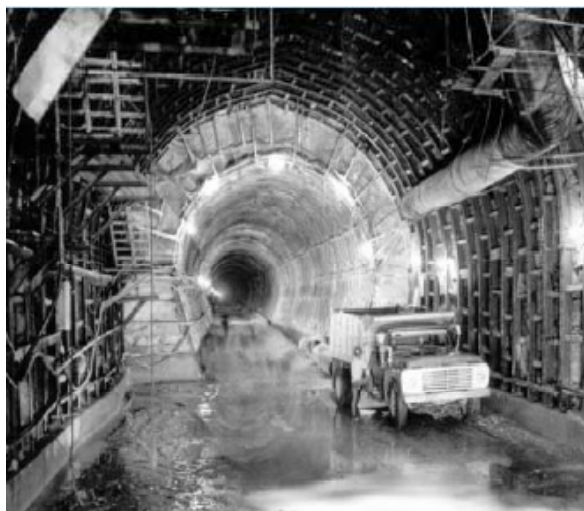
Fig. 1.3.2 Creación de una parte del sistema de alcantarillado.
