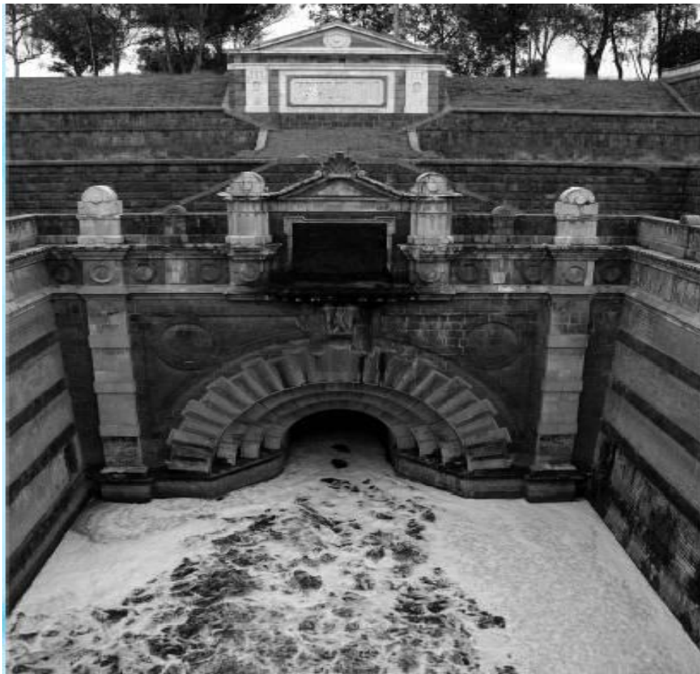
Fig. 1.2.5 Gran Canal del desagüe
