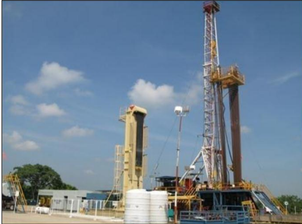
Figura 6.6 Esquema de producción en frío con inyección de diluyente; BM tipo Rotaflex
