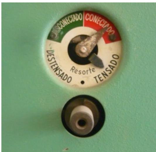
Fig. 3.11 Ranura para conexión de Manivela para el tensado del resorte
