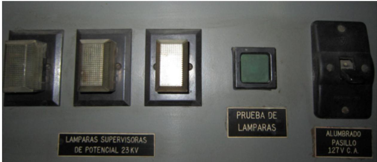
Fig. 3.4 Lámparas supervisoras de potencial, botón de prueba de lámparas e interruptor de alumbrado
