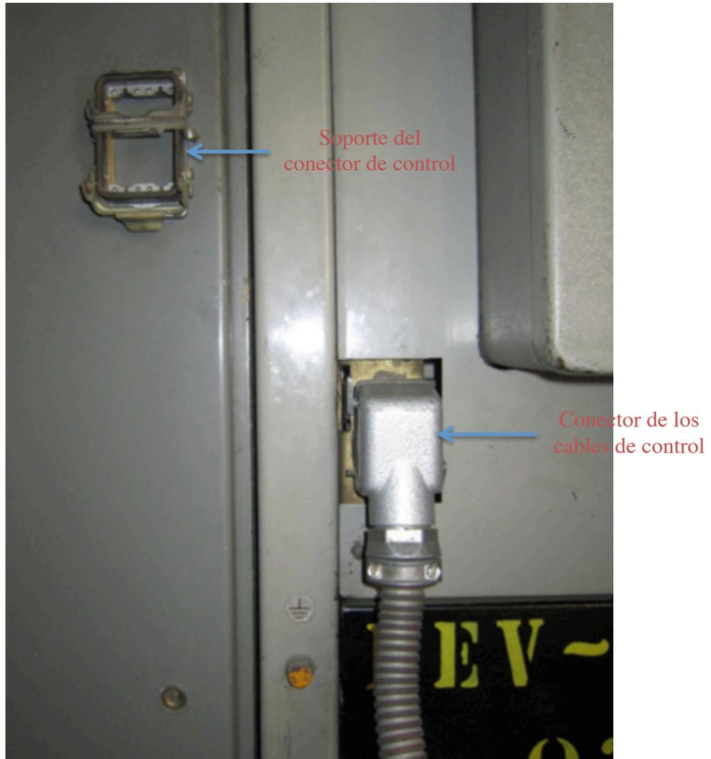
**Fig. 3.8 Conector para el control, y soporte del conector**
