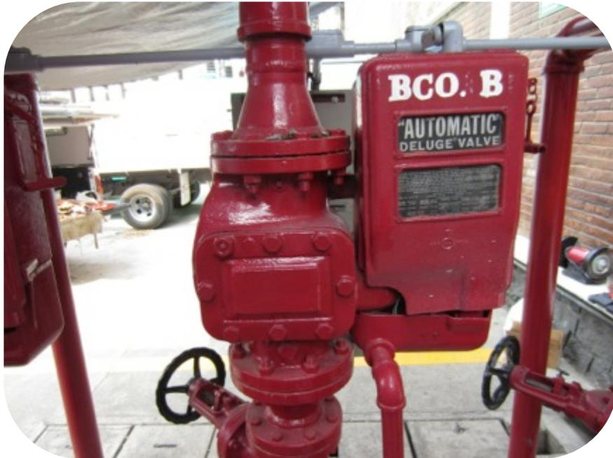
Para activar el Sistema Contra Incendio de forma manual basta únicamente con jalar la palanca que se muestra en la imagen anterior, teniendo en consideración que se tiene una para cada transformador, por lo que se deberá antes de jalar la palanca identificar correctamente la que corresponda al transformador en disturbio, además se deberá verificar que el transformador se encuentre desenergizado.
