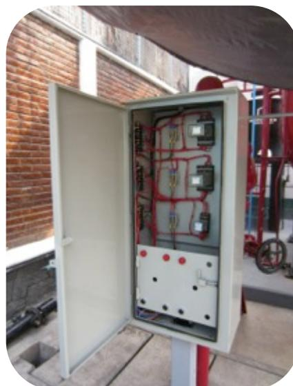
Se cuenta con un gabinete (imagen lado izquierdo) donde se aloja la estación de control de la moto-bomba y el moto-compresor; y en la imagen del lado derecho se tiene un relevador de bloqueo definitivo (23X) para cada uno de los transformadores con lámpara de señalización de operación y botón de reposición para cada uno.
