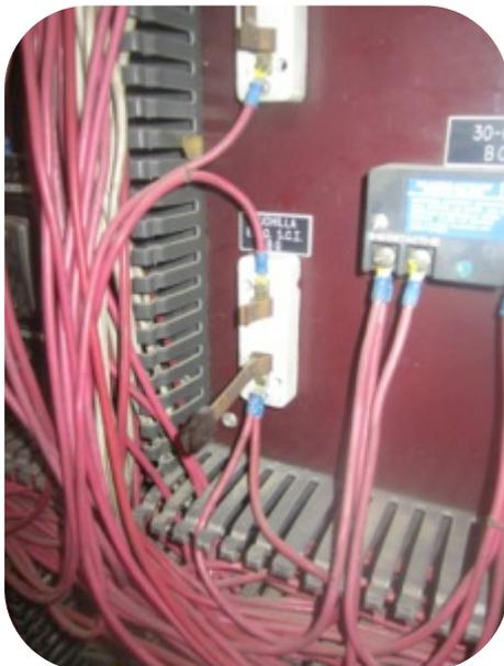
Se encuentra instalada en la parte posterior de los tableros de protección de cada uno de los transformadores. Al abrir esta cuchilla bloquea la operación automática del SCI.
