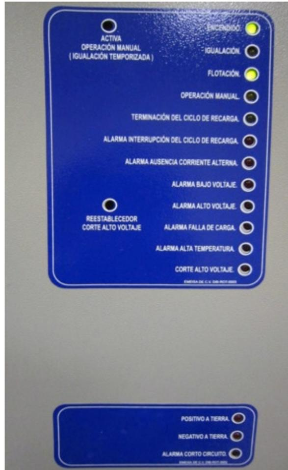
Fig. 4.12 Panel de Alarmas de Cada Cargador de Baterías
