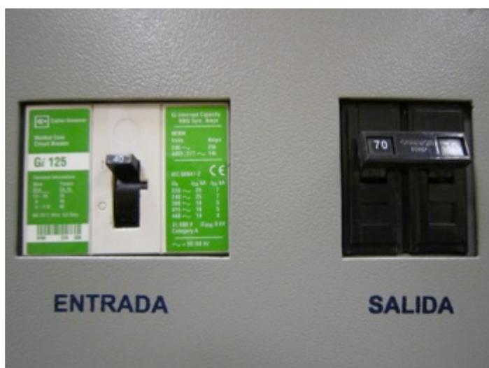
Fig. 4.11 Termomagnéticos de Entrada y Salida de los Cargadores de Batería
