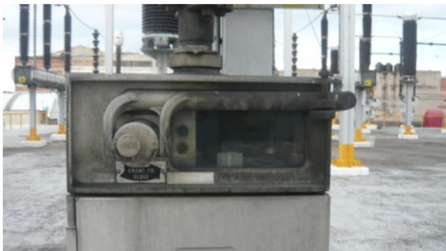
**Fig. 2.17 Palanca de Operación Manual**
