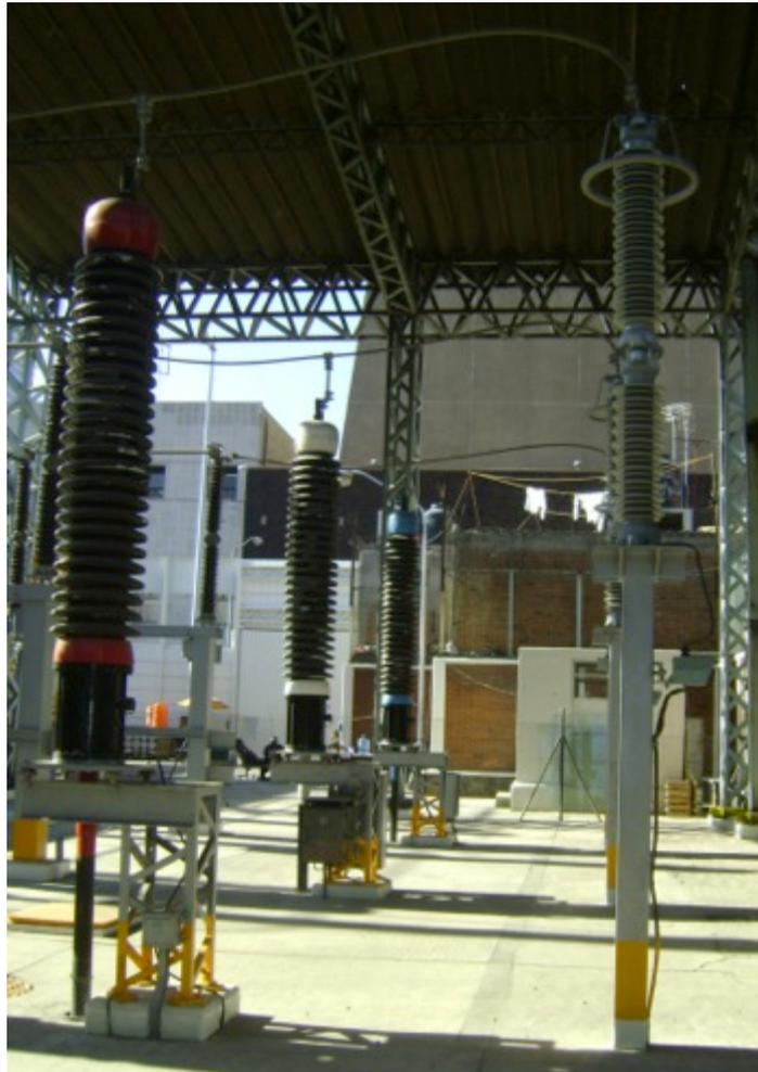
**Fig. 2.33 Terminales de los cables de potencia**
