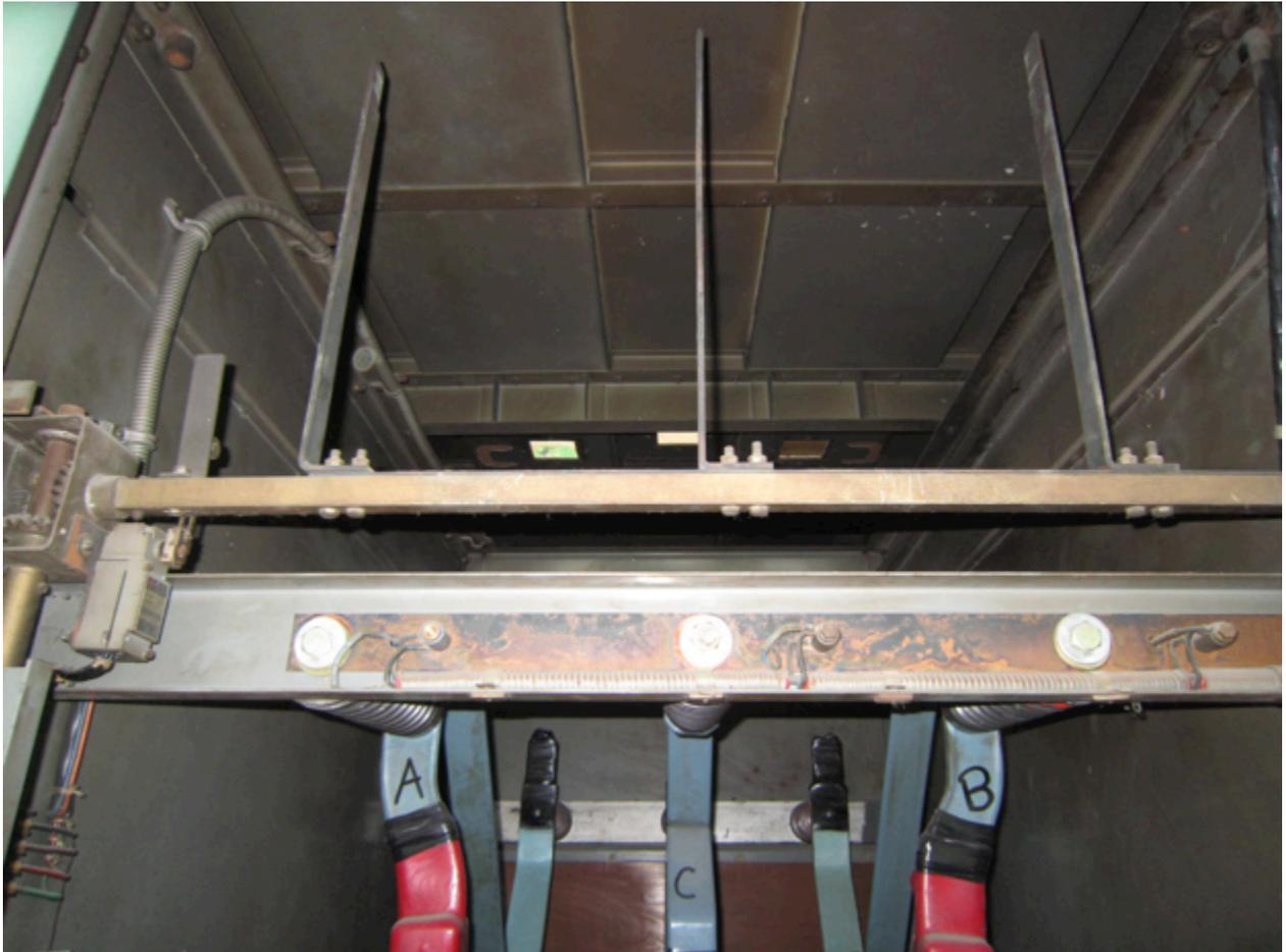
**Fig. 3.9 Cuchillas de puesta a tierra (Ubicadas en la parte posterior de cada alimentador)**
