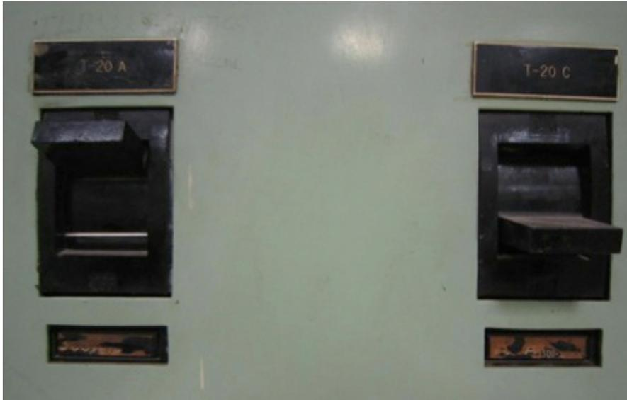
Fig. 3.17 Interruptores Termomagnéticos de los Transformadores de S.P.
