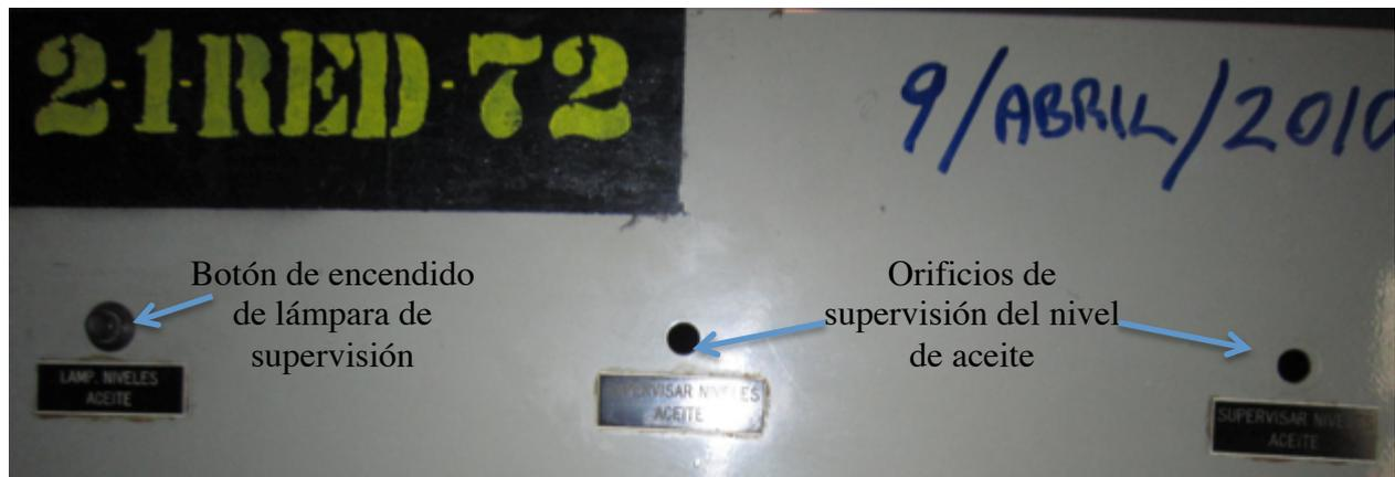
Fig. 3.5 Botón de encendido de lámparas y orificios de supervisión de nivel de aceite
