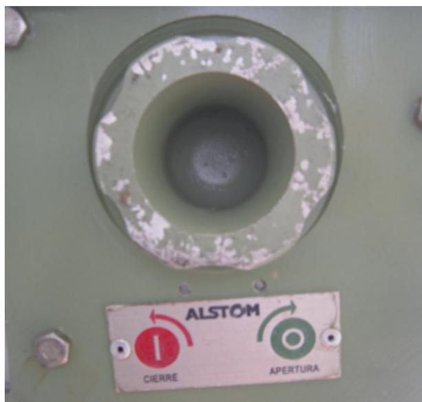
Fig. 2.21 a) Ranura de Inserción en la parte inferior del gabinete de control
