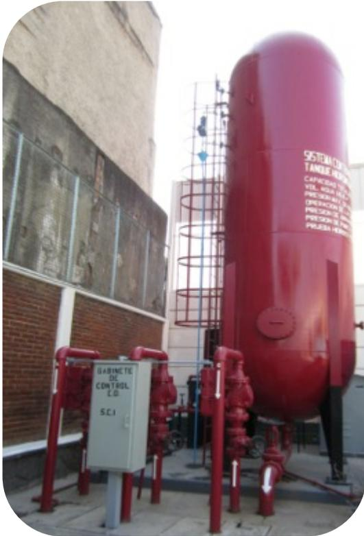
Depósito de 30 m<sup>3</sup> de capacidad donde se almacena 20 m<sup>3</sup> aproximadamente de agua y el volumen restante del tanque se presuriza a 7 Kg/cm<sup>2</sup>.
