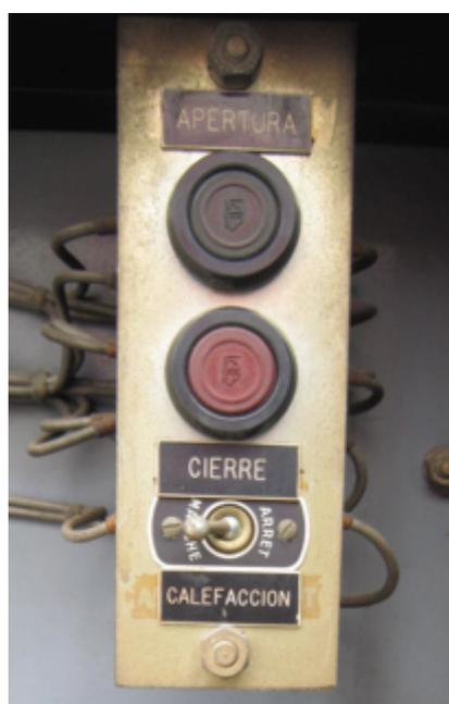
Fig. 2.23 a) Operación Local Modo Eléctrico
