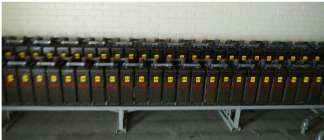
Fig. 4.9 Banco de Baterías de la S.E. Pensador Mexicano
