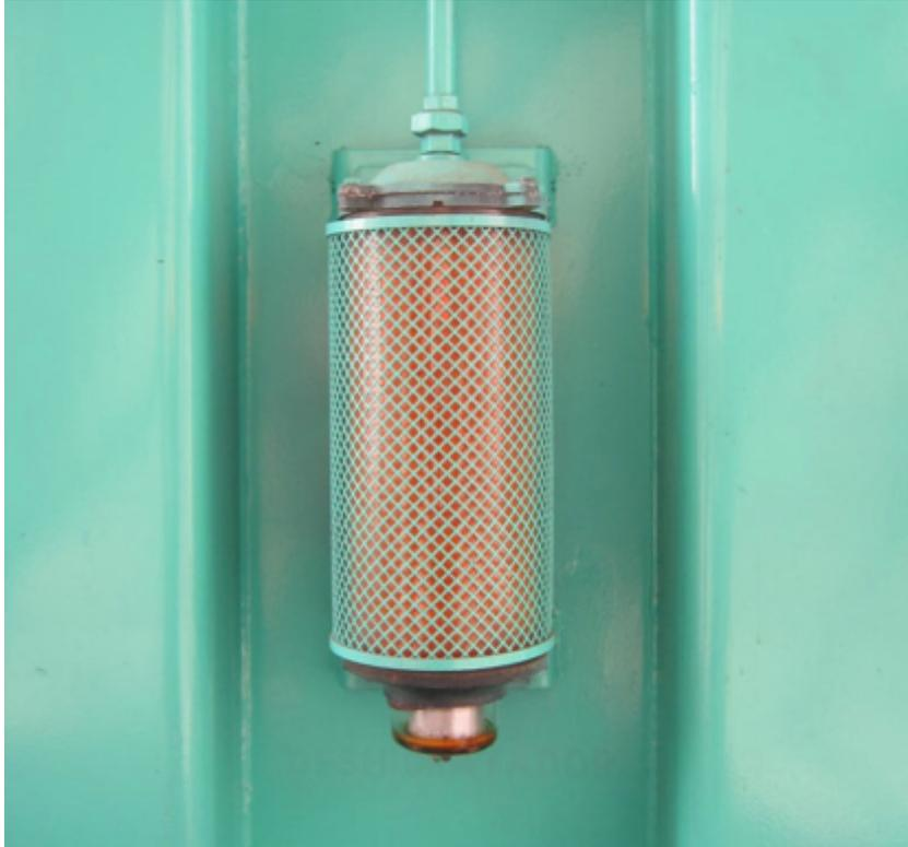
**Fig. 2.3 Sistema de Preservación del Aceite (Sílica Gel)**
