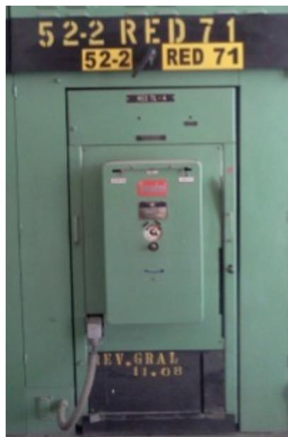
Fig. 3.1 Vista Frontal del Interruptor Tipo Metal Clad
