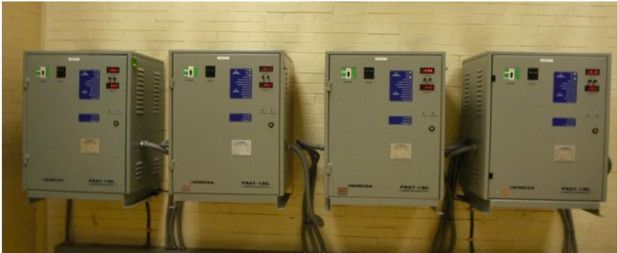
Fig. 4.10 Cargadores de batería de la S.E. Pensador Mexicano
