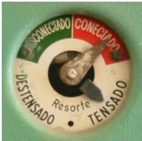
Fig. 3.6 Indicadores del estado del interruptor y resortes
