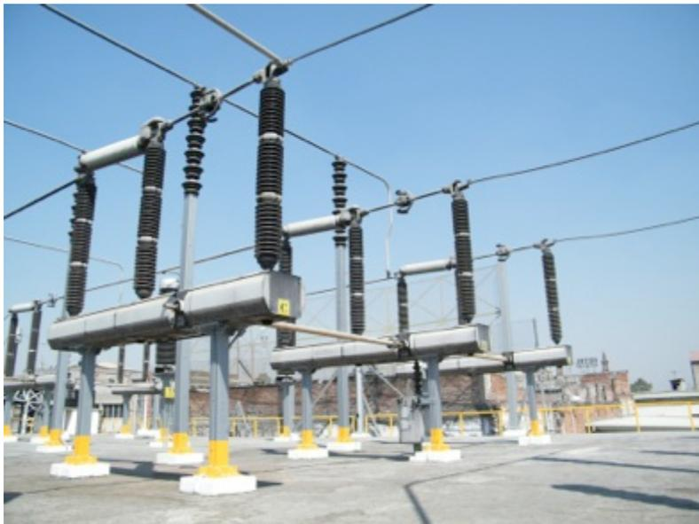
Fig. 2.15 Cuchillas Seccionadoras de Apertura bajo Carga
