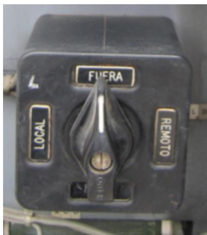
Fig. 4.22 Selector de Mandos de las Cuchillas de los Bancos de Transformación
