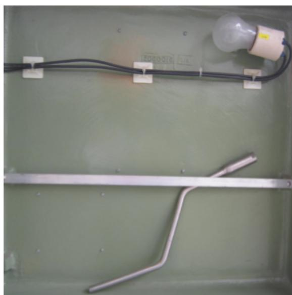
Fig. 2.21 b) Manivela e iluminación dentro del gabinete de control
