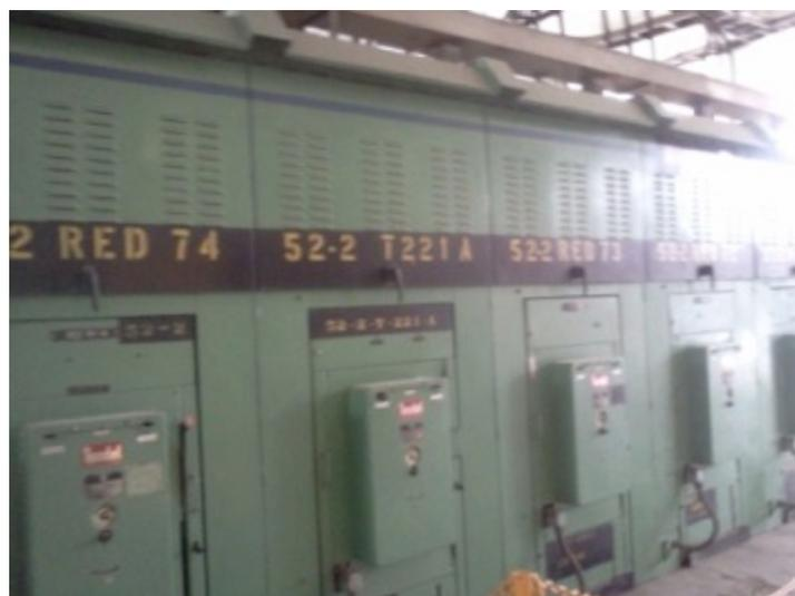
Fig. 3.2 Interruptores Tipo Metal Clad
