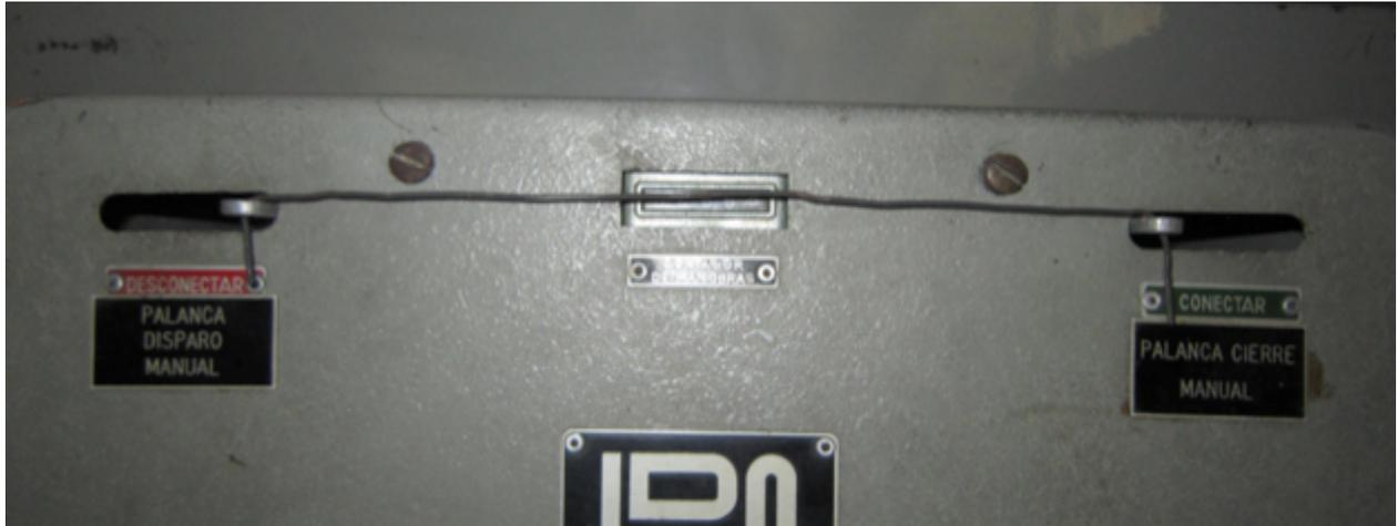
Fig. 3.6 Palanca de disparo manual, contador de operaciones y palanca de cierre manual
