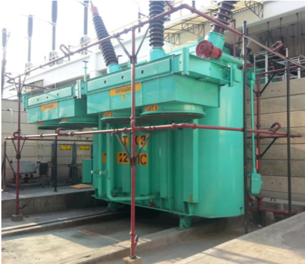
Es un conjunto de tuberías a dos niveles por la cual se conduce el agua hacia las toberas o rociadores.
