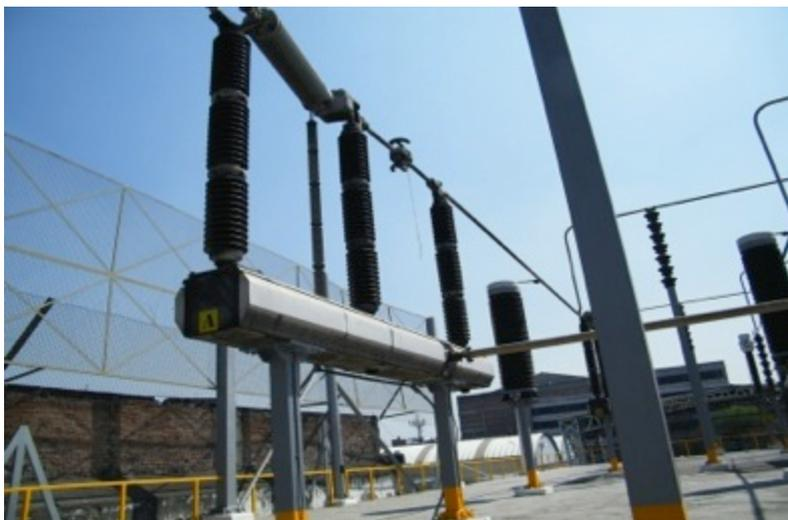
Fig. 2.16 Cuchillas Seccionadoras de Apertura bajo Carga
