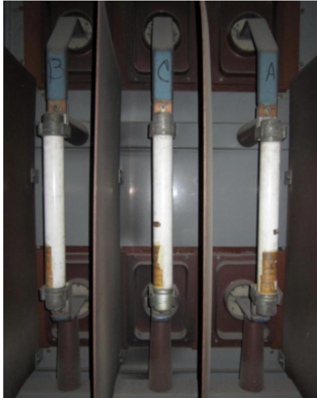
Fig. 3.14 Fusibles de los transformadores de servicios propios.
