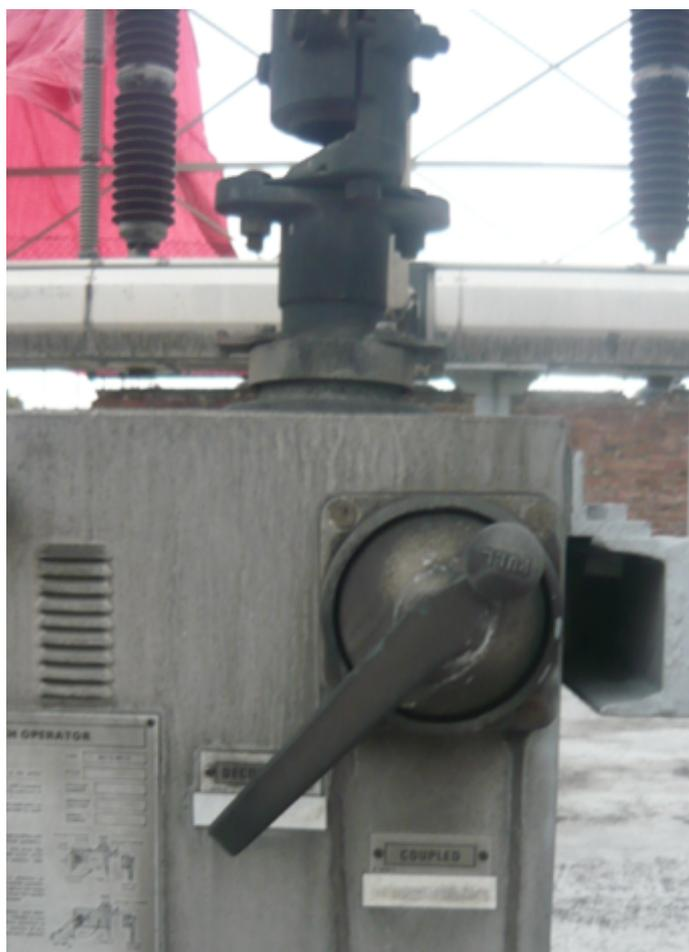
**2.18 Mecanismo de bloqueo de la cuchilla de 230 kV de operación bajo carga**
