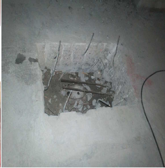
Pozo de tensado (nervaduras).
