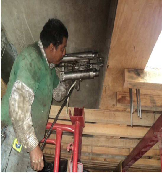
Tensado de torones.
