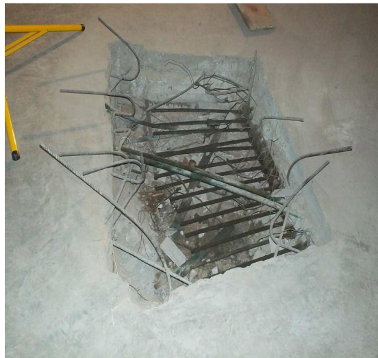
Pozo de tensado (contratraves).
