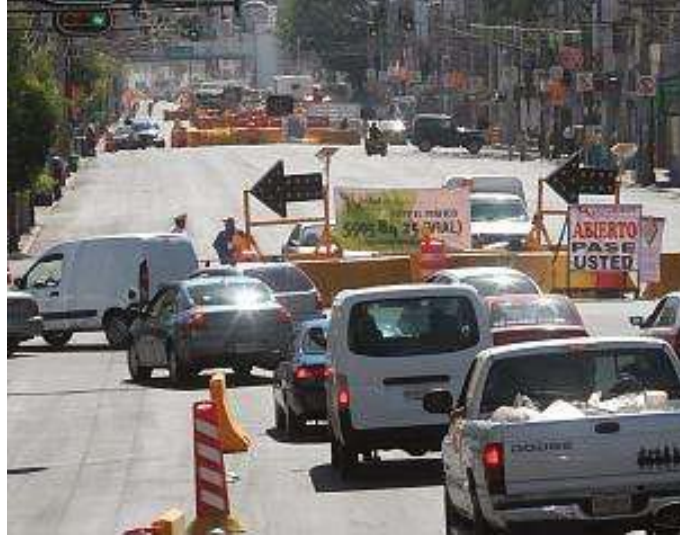
Fuente: Imagen tomada en la Av. División del Norte esquina eje 8
