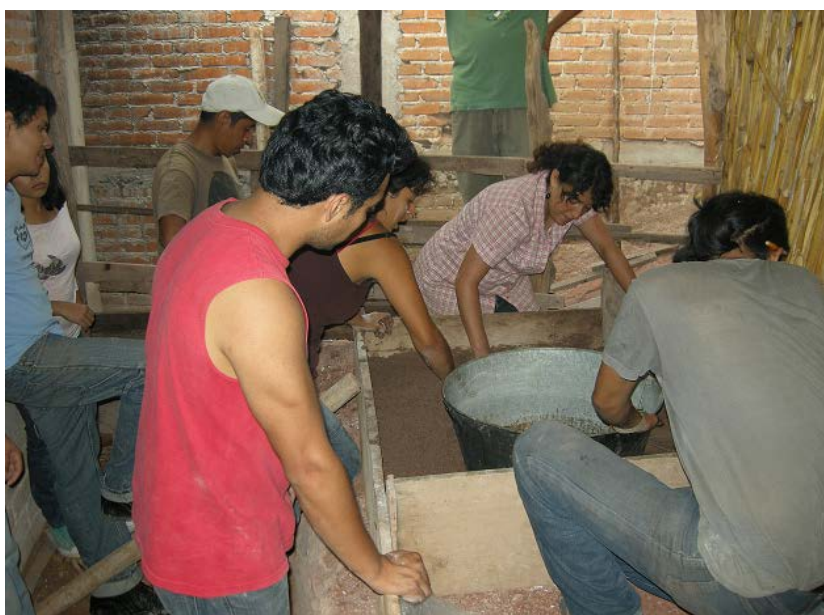
Figura 38. Construyendo estufas en Xalpatláhuac. Julio de 2011.
