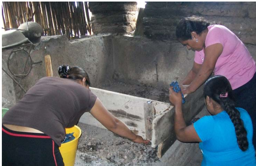
Figura 40. Mujeres construyendo su estufa en Tototepec. Julio de 2012.
