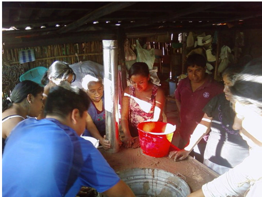
Figura 32. Mujeres de Xalpatláhuac construyendo estufas con mano vuelta . Marzo de 2010.
