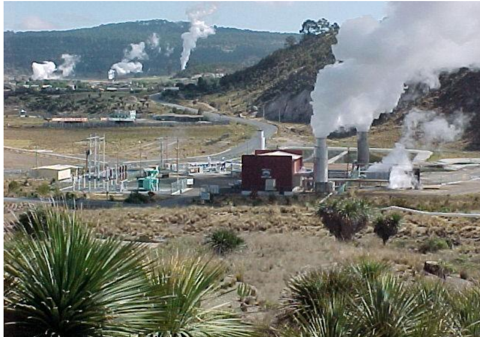
Figura 1.33.- Campo geotérmico “Los Hornos” 30
