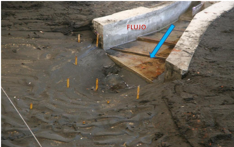
Imagen 7.1.1 Detalle de escalones disipadores de energía y reducción de velocidad en obra de margen Izquierda
