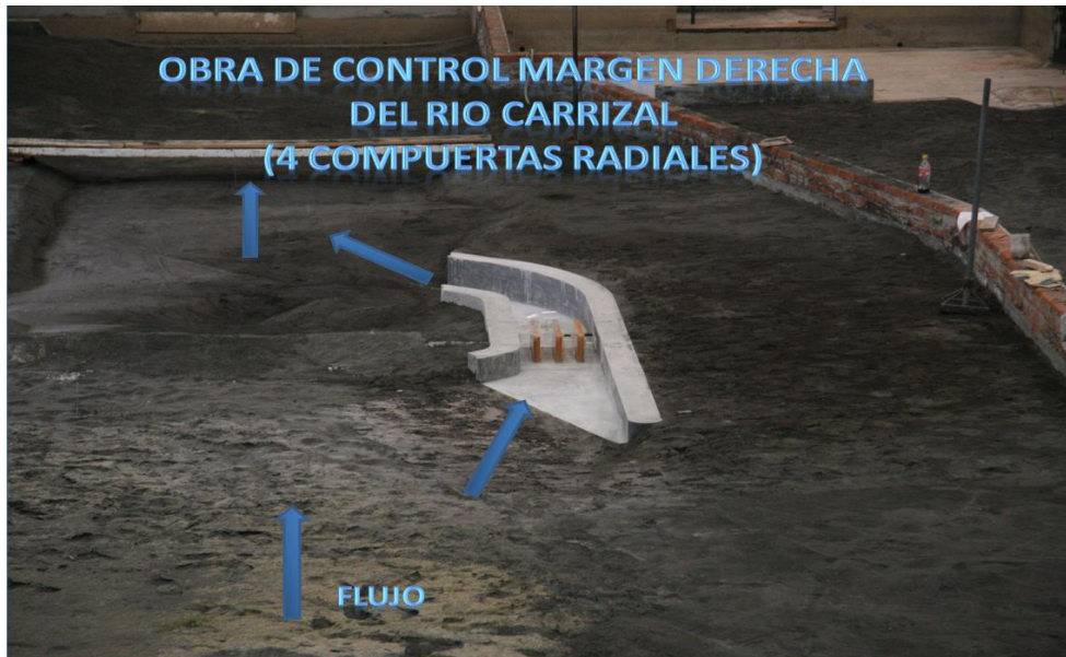
Imagen 7.1.2 Estructura de margen derecha vista desde aguas arriba de la estructura
