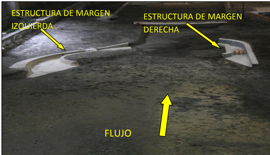
Imagen 6.2.2 Estructuras sobre el río Carrizal
