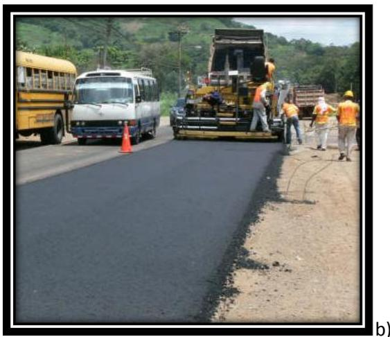
**FIGURA 4-2. PAVIMENTO ASFÁLTICO.**
