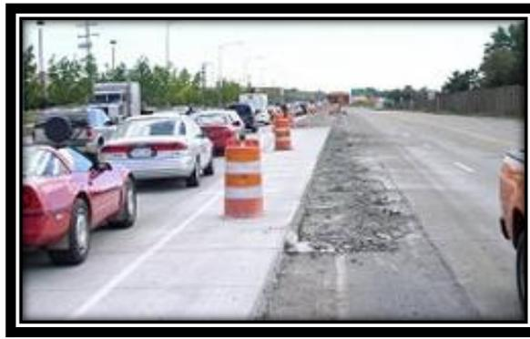
**FIGURA 4-1. PAVIMENTO WHITETOPPING. a) Esquema de pavimentación con whitetopping. b) Whitetopping sobre pavimento viejo.**
