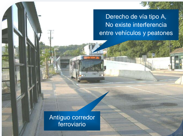
Imagen 1.10 Vista al carril confinado en el sistema West BusWay de Pittsburg, EUA.
