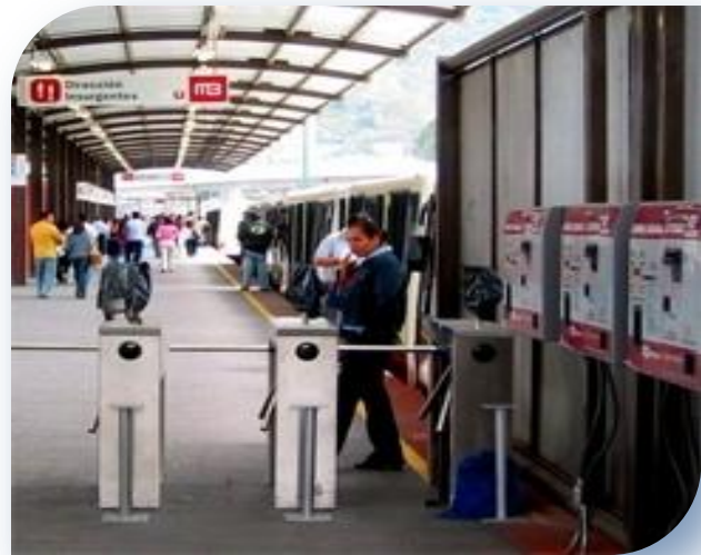
Imagen 1.17 Empleo de torniquetes como barrera física de acceso y para verificación de pago. Sistema
