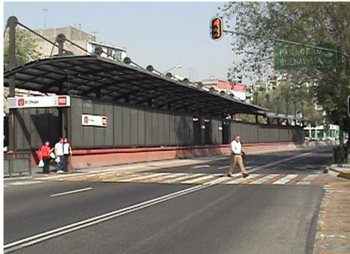
VISTA EXTERIOR DE LA ESTACIÓN
