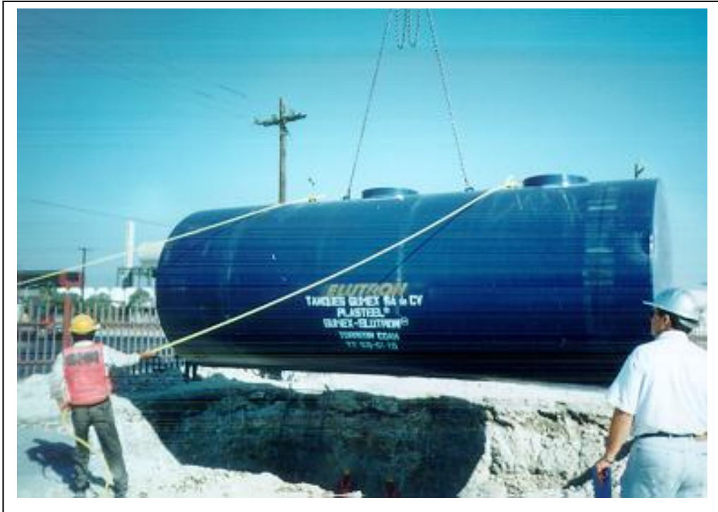
Foto 7 Revisión de los tanques antes de su colocación
