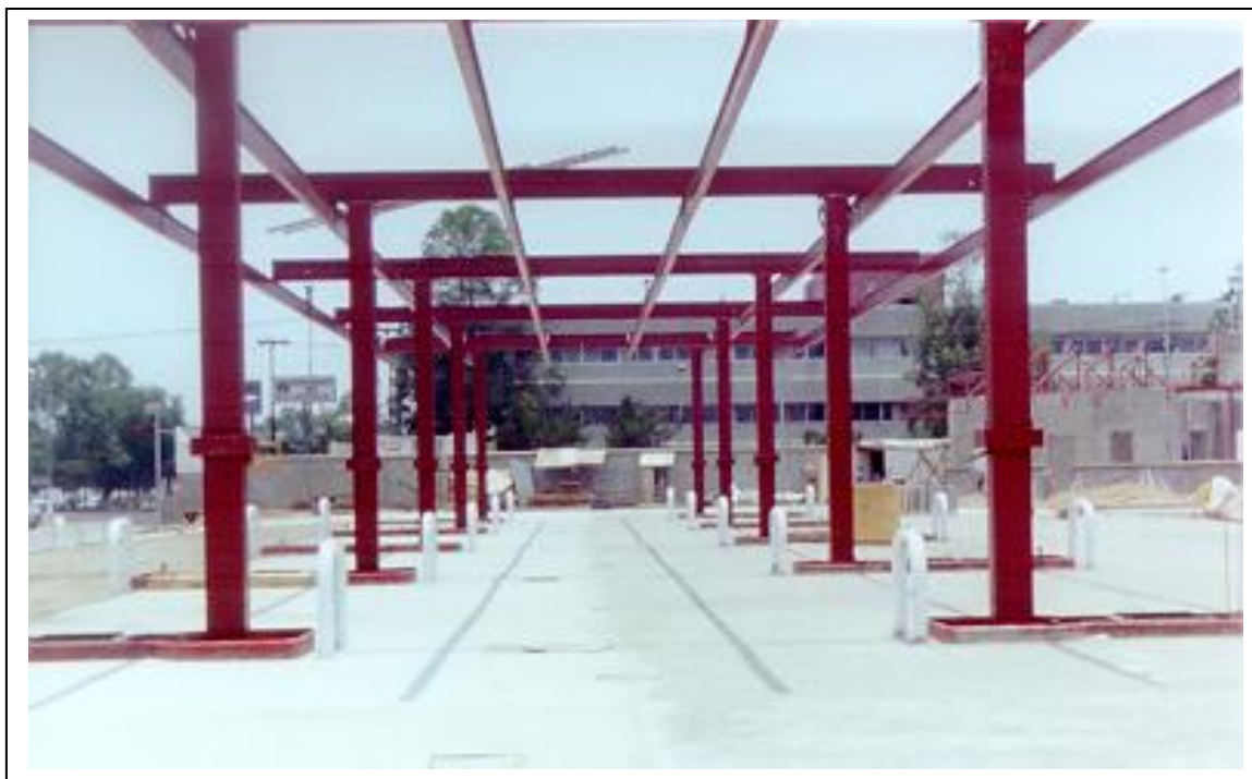
Foto 14 Estructura de techumbre terminada
