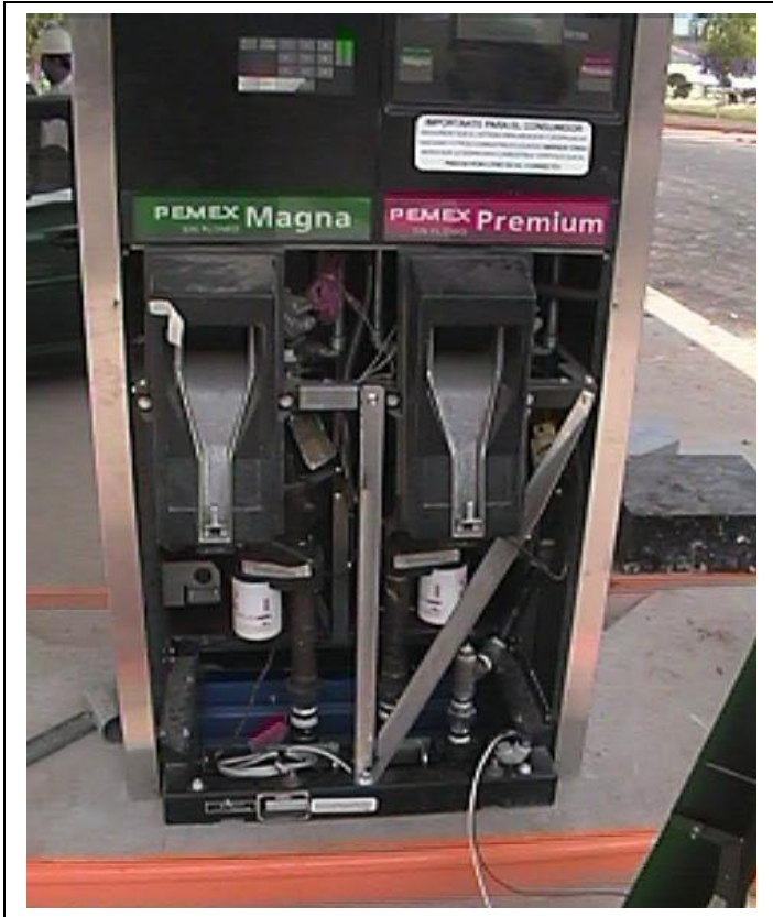
Foto 23 y 24 Conexión de dispensarios
