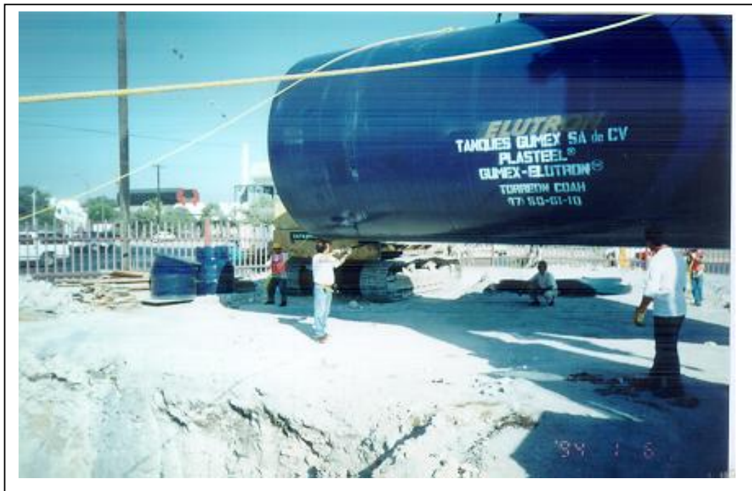
Foto 6 Colocación tanques de almacenamiento
