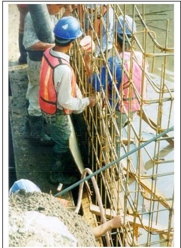
Foto 4 Armado de acero para refuerzo de la fosa de concreto para los tanques de almacenamiento
