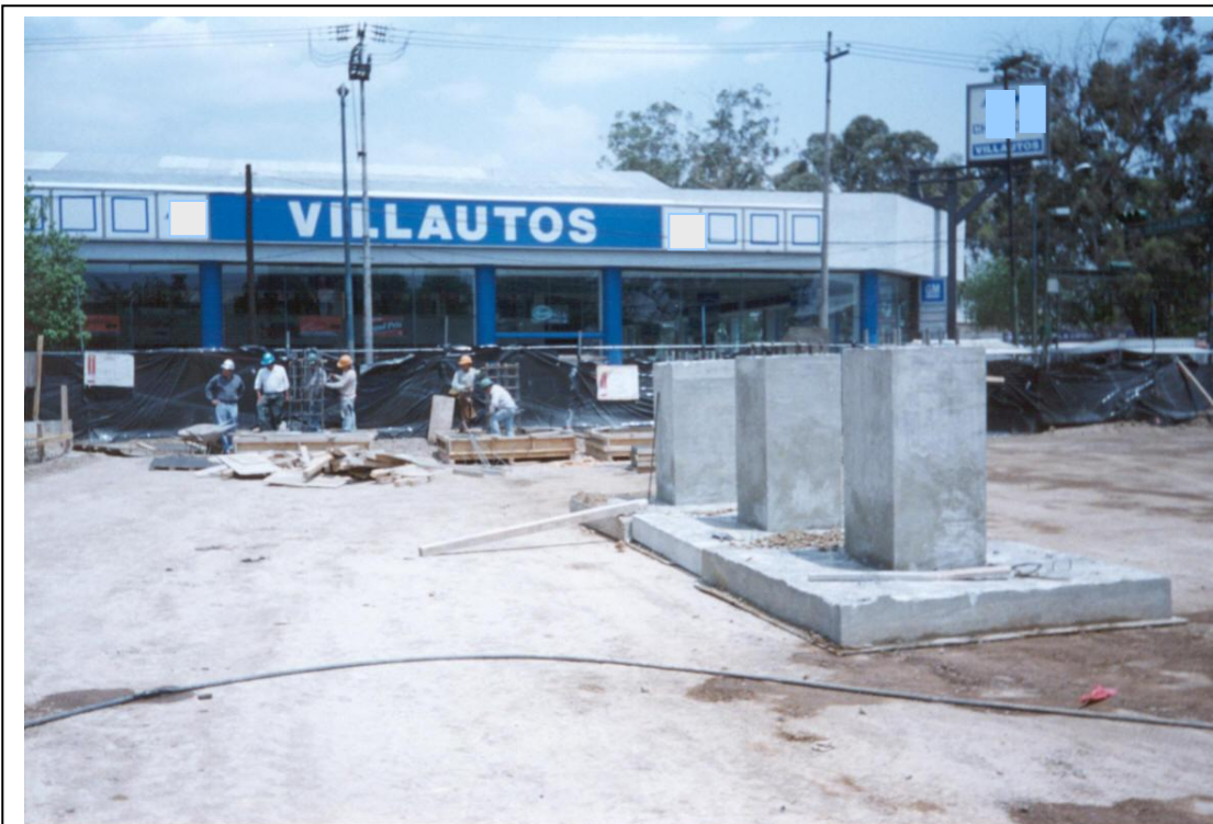
Foto 11 Preparación y armado de zapatas para techumbre (precoladas)
