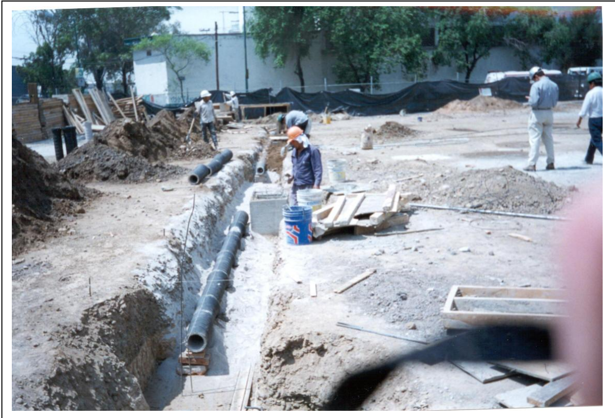
Foto 15 Tendido de tubería para aguas aceitosas
