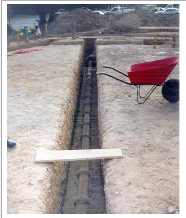
Foto 16 Tendido de tubería para drenaje sanitario
