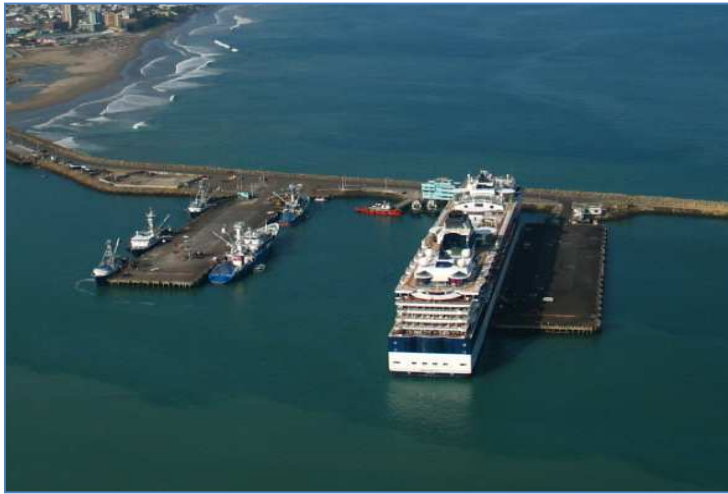
Figura 4 Muelles en espigón (Muelles internacionales 1 y 2) (Fuente: Puerto de Manta, Ecuador. Proyecto de expansión del puerto)
