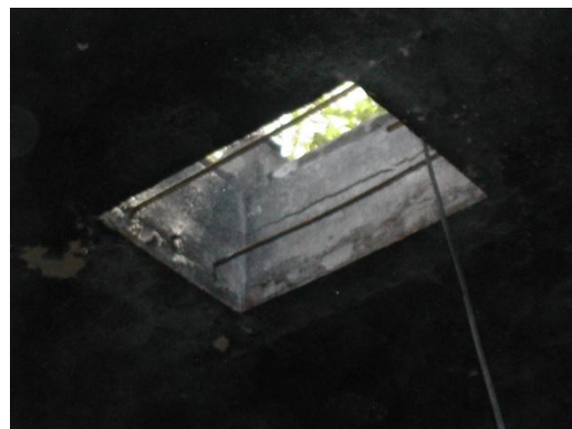
Fotografías de la extracción de la barra de acero No. 3.
