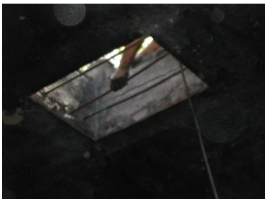
Fotografías de la extracción de la barra de acero No. 3.
