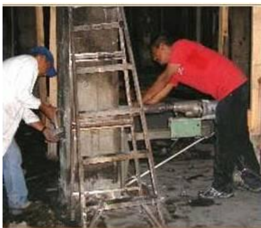
Figura 1. Se presenta la forma en la que fue colocado el equipo de extracción para la obtención de muestras de concreto.
