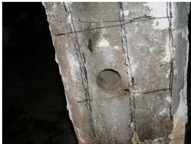
Figura 6. En la columna que se presenta es posible observar la distribución del acero de refuerzo
