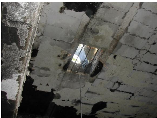
Fotografías de la extracción de la barra de acero No. 4.
