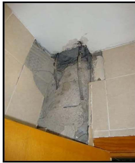
Figura b. Desprendimiento de recubrimiento, colocado en algunas columnas como reparación del original, pandeo local del refuerzo por escasez de estribos en la zona
