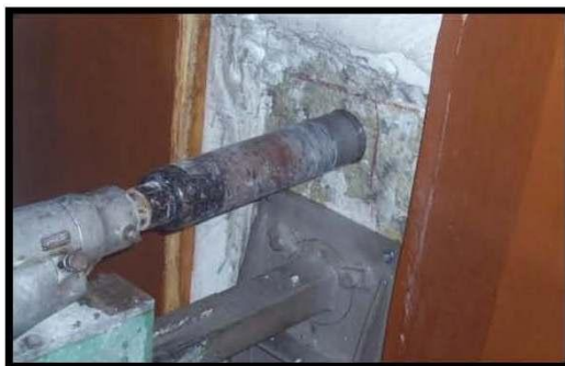
Figura 1. Se presenta la forma en la que fue colocado el equipo de extracción para la obtención de muestras de concreto.
