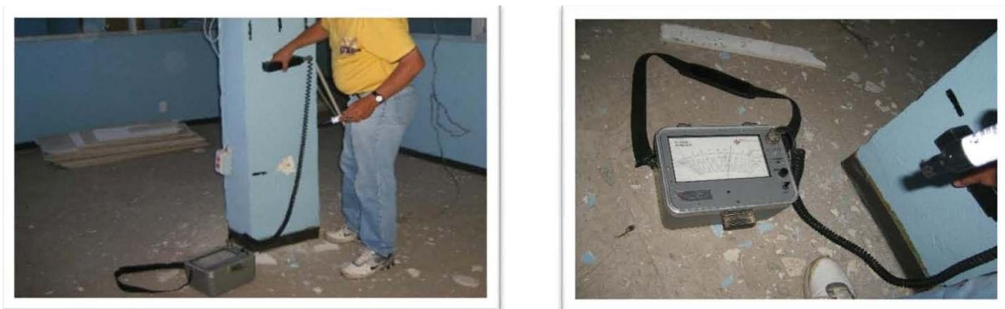
Figura II.VIII Toma de detección de acero en una columna
