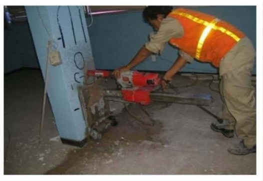
Figura II.X Extracción de núcleos de concreto
