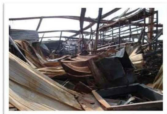
Figura II.III vista de los daños en la estructura metalica en un inmueble propiedad de home depot
