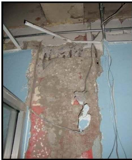
Figura b. Desprendimiento de recubrimiento, colocado en algunas columnas como reparación del original, pandeo local del refuerzo por escasez de estribos en la zona
